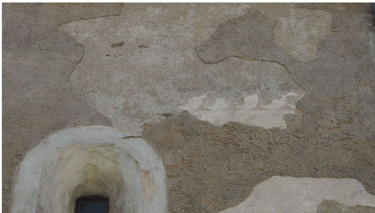
Obr. 46 Dešná, kostel sv. Jana Křtitele, detail pletence na sgrafitové úpravě fasády lodi související s renesanční úpravou kostela, foto: Zdeňka Míchalová.
