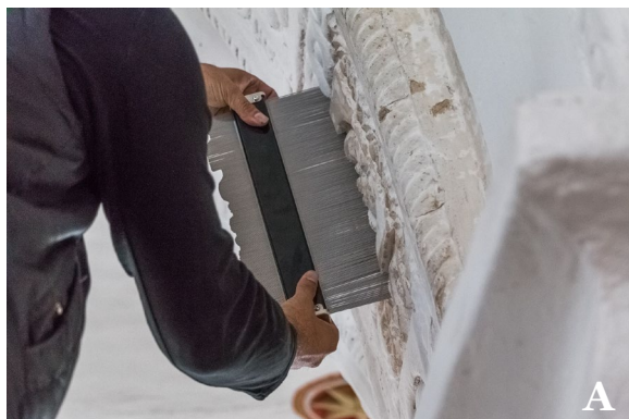
Snímání štukového profilu pomocí hřebenu.
