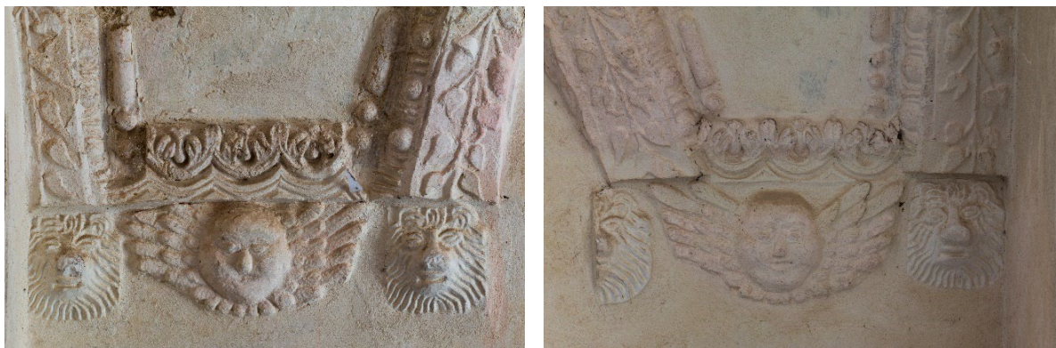
Obr. 63 Dešná, kostel sv. Jana Křtitele, předsín, na konzolách pod pasy kleneb a na otisku lva v severozápadním rohu předsíně jsou dosud zachované depozity po separaci hliněným šlikrem a známky po sejmutí formy, a konzole na protější straně jsou lví hlavy nahrazeny sádrovými kopiemi, foto: Vojtěch Krajíček.
