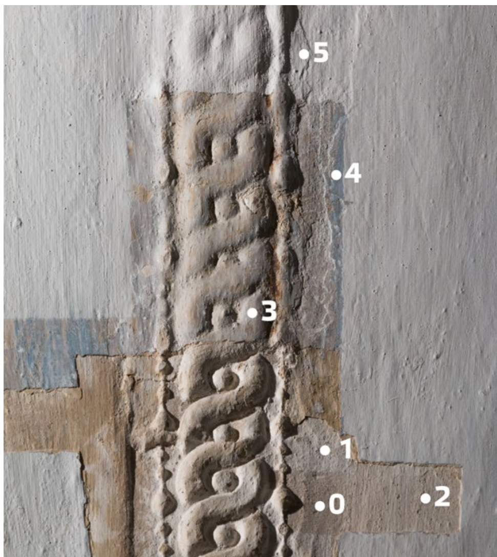
Obr. 37 Polička, kostel sv. Michala, sonda rozkrývající starší barevná řešení a původní modelaci štuků, foto: Vojtěch Krajíček.
