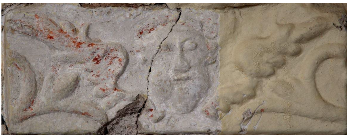
Obr. 14 Hostěradice, stará radnice, detail konzolky klenebního pásu, v sondě jsou patrné fragmenty barevných akcentů červenou linkou, foto: Zdeněk Kovářik.
