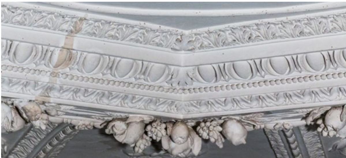
Obr. 13 Letohrádek Hvězda, detail profilací s otiskovanými ornamenty rámuující jednotlivé výjevy. Modelované reliéfy i otiskované prvky byly původně bez nátěrů, barevnost tvořila hmota bílého štuky. V současné době jsou štukové dekorace opatřeny několika scelujícími bílými nátěry, foto: Vojtěch Krajíček.
