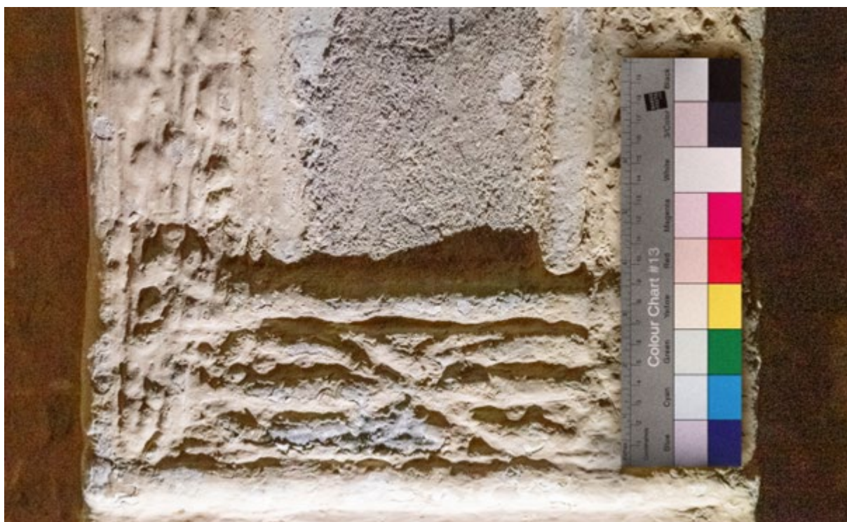
Obr. 20 Znojmo – dům čp. 284, tzv. „domácí kaple“, razantní boční nasvětlení vytlačovaného štku použité pro studium dekoru a jeho poškození, foto: Vojtěch Krajíček.
