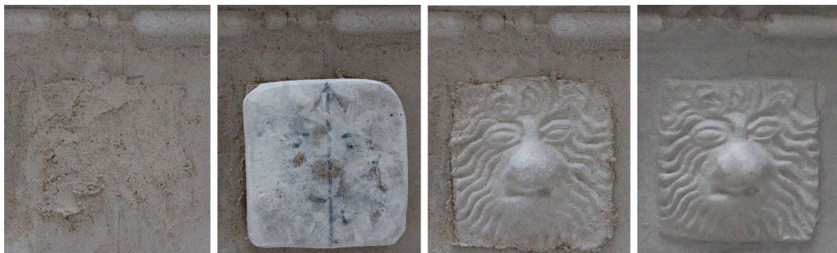
Obr. 57 Postup zhotovení otisku lví hlavy: 1) příprava podkladové omítky a zdrsnění povrchu, 2) přitisknutí štku s formou, 3) stav po sejmutí formy, 4) stav po plastické retuši, foto: Zdeněk Kovářík.
