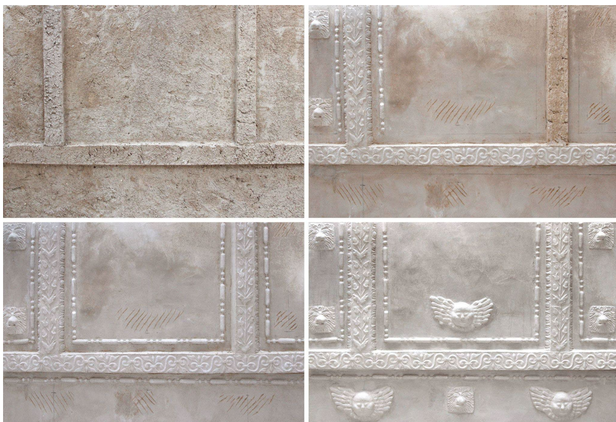
Obr. 58 Volná kopie části renesanční štukové výzdoby v Dešné replikující postup vytváření dekorace – příprava podkladu i s vytaženými žebry, postupné budování jednotlivých ornamentů, foto: Zdeněk Kovářik.
