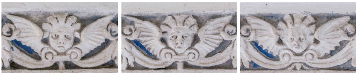
Obr. 17 Zámek Bučovice, Císařský sál, detail otisků s motivem netopýra, patrné korekce po otištění formy, foto: Vojtěch Krajiček.
