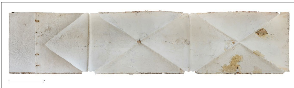
Obr. 28 Fotogrammetrický snímek klenby renesanční arkády na zámku Neustupov, klenba byla nasnímána fotoaparátem Canon 90D s objektivem Canon EF-S 10–18 mm f/4,5–5,6 IS STM. Nasbíraná data byla zpracována v programu Agisoft Metashape Professional. Korektura výsledného snímku v programu Adobe Photoshop CC (2021), foto: Vojtěch Krajíček.
