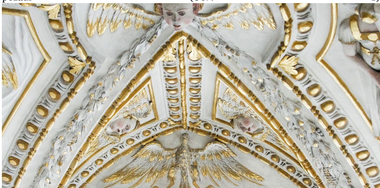
Obr. 1 Zámek Telč, kaple Všech svatých, klenba presbytáře, zlacení akcentů na dekorativních ornamentech rámuujících jednotlivé výjevy, foto: Zdeněk Kovářik.
