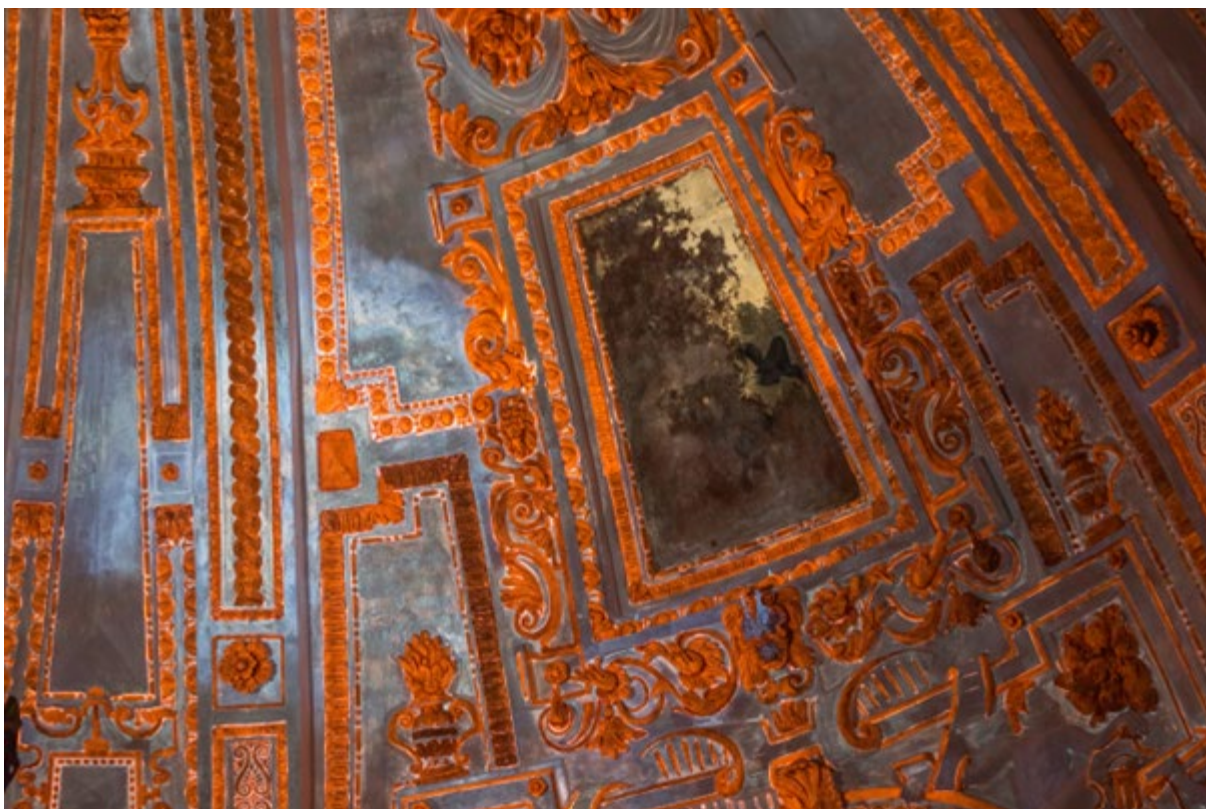
Obr. 25 Jindřichův Hradec, Rondel, UVF snímek klenby. Světle modrá fluorescence ukazuje zasolené místo vzniklé po zatékání vody. Oranžová fluorescence dokazuje použití šelaku (podle intenzity oranžové fluorescence je možné orientačně posuzovat sílu šelakového nánosu), foto: Vojtěch Krajíček.
