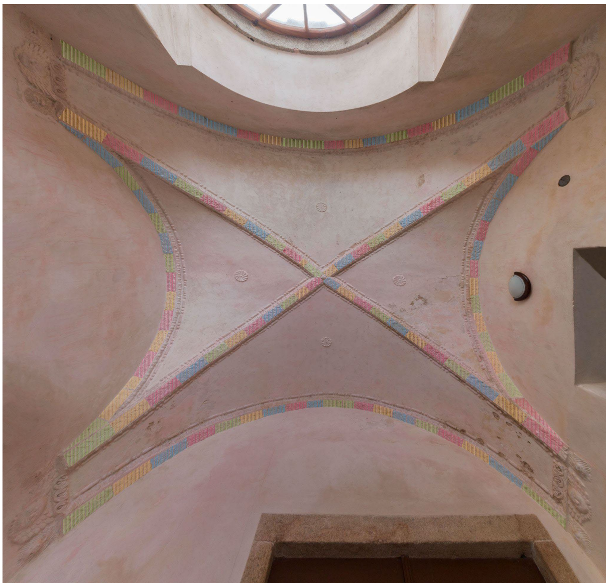
Obr. 53 Systém skládání forem na klenbách žebrech, každý klenební pás je ve vrcholu rozdělen a na každé straně je rytmus kladení ornamentu odlišný, foto a grafická úprava: Vojtěch Krajčec.
