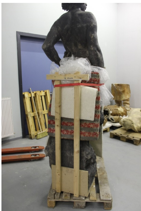
Obr. 22, 23 Dřevěná konstrukce pro přesun sochy v rámci galerijních prostor. Spodní a zadní deskou jsou chráněny ohrožené partie nároží plintu.
