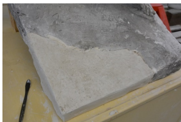
Obr. 15: V případě doplnku podstavce u alegorie Ochrany byl zvolen jako podpůrný prvek sádra vyztužená gázou, která se aplikovala z vnitřní strany odlitku přes lepený spoj.
