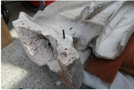
Obr. 24: Připevnění sádrového odlitku plintu pomocí sklolaminátového čepu.
