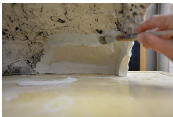
Obr. 15: V případě doplnku podstavce u alegorie Ochrany byl zvolen jako podpůrný prvek sádra vyztužená gázou, která se aplikovala z vnitřní strany odlitku přes lepený spoj.
