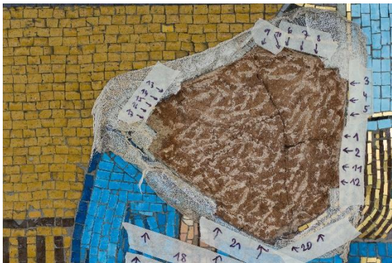
Ukázka zásahu – stav po vyjmutí uvolněné oblasti a redukci původní ložné malty.
