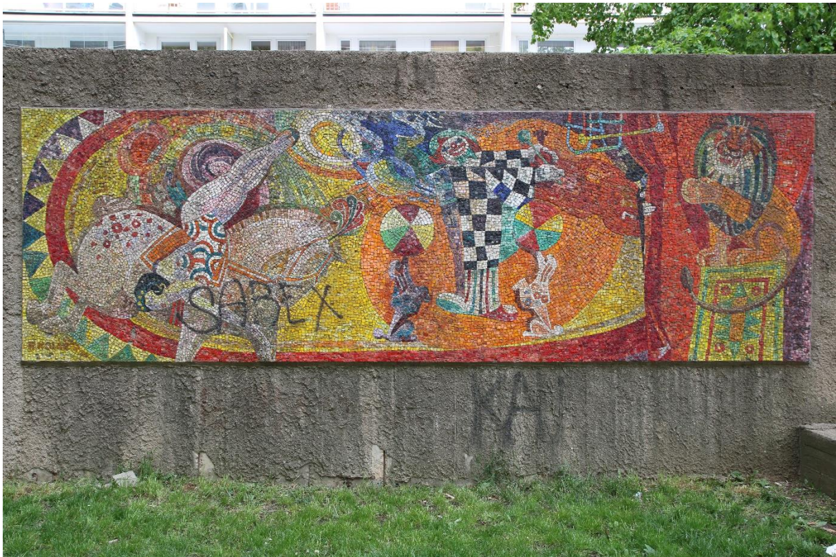
Obr. 12: Celkový pohled na mozaiku Radomíra Koláře s názvem Cirkus . Stav před restaurováním.
