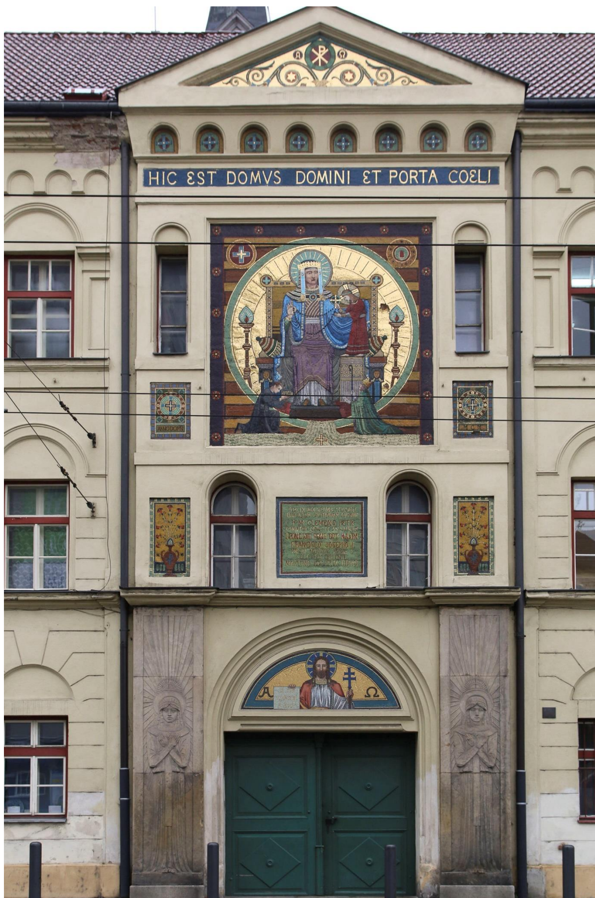
Obr. 1: Celkový pohled na mozaiku na průčelní fasádě kostela Panny Marie Růžencové v Českých Budějovicích. Stav před restaurováním.
