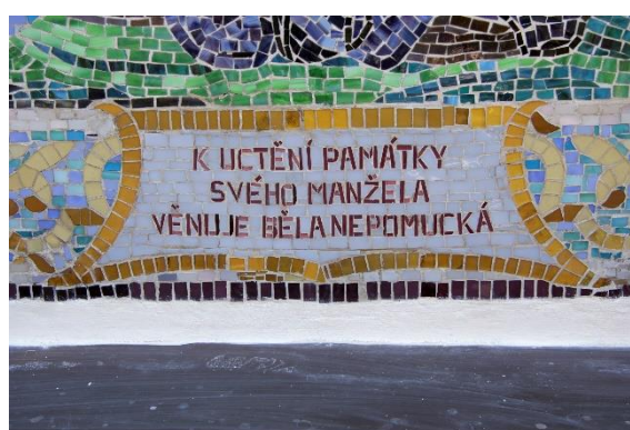
Stejný detail mozaiky po vyjmutí druhotného doplňku a rekonstrukci původního znění textového pole dle historické fotografie.
