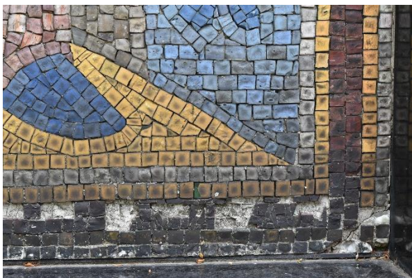
Detail povrchového znečištění mozaiky a chybějících mozaikových kostek. Stav před restaurováním.
