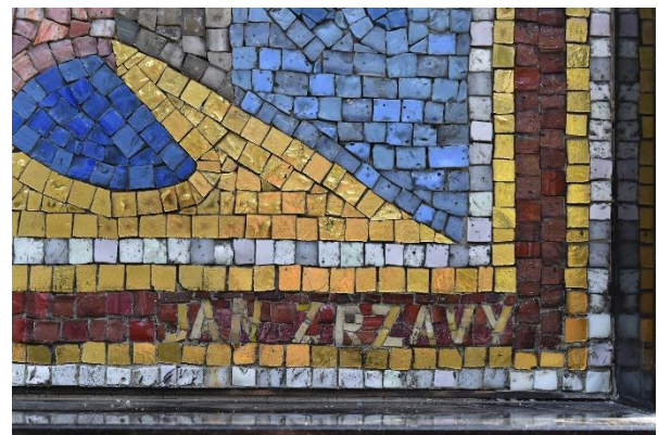
Stejný detail mozaiky po očištění povrchového znečištění, konsolidaci uvolněných mozaikových kostek a doplnění.
