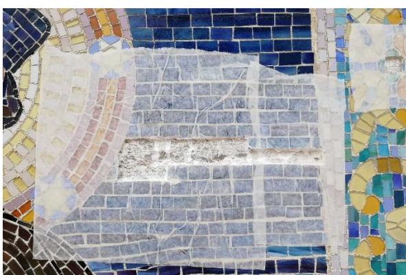
Obr. 20: Detail mozaiky na průčelí kostela v Táboře-Klokotech. Defekt připravený pro znovuosazení skleněných dílků – stav po zajištění okolí přelepem, jeho konsolidaci a redukcí původní osazovací malty.
