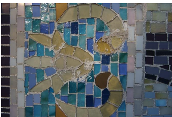
Obr. 22: Detail mozaiky na průčelí kostela v Táboře-Klokotech. Znovuosazené skleněné dílky před začišněním osazovací malty.
