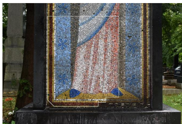
Obr. 36: Mozaika na náhrobku Jana Tumpacha na Vinohradském hřbitově. Rozšířená zkouška čištění pomocí mikrobrusky a kotoučů z jemného brusného rounda.
