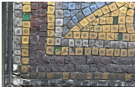
Obr. 7: Detail poškození mozaiky na náhrobku Jana Tumpacha – povrchové znečištění mozaikových kostek a degradace zlatých kostek.
