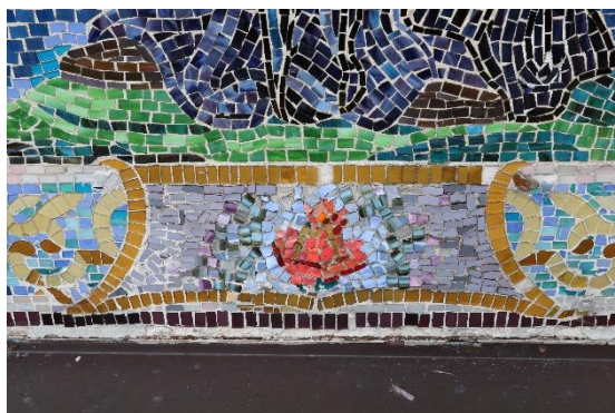
Obr. 11: Detail mozaiky s motivem Jana Nepomuckého – nahrazení původního nápisového pole neuměle zpracovaným mariánským motivem.
