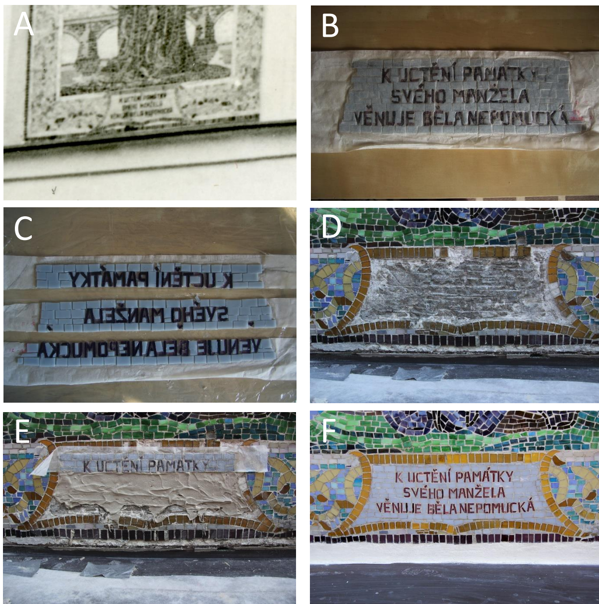
Obr. 37: Postup rekonstrukce části mozaiky s motivem Jana Nepomuckého: a) výřez historické fotografie s původním obsahem textového pole na spodní straně mozaiky, b) nově vytvořená rekonstrukce textového pole, c) příprava na osazení – nařezání na části, d) oblast textového pole po odstranění druhotných zásahů a redukcí původní ložné malty, e) průběh osazování rekonstrukce, f) stav po osazení a vyretušování spár.
