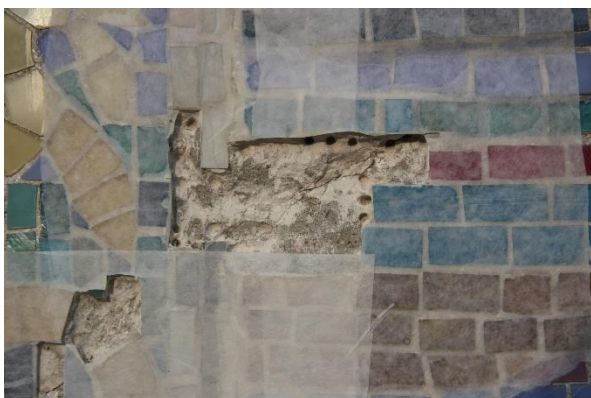
Obr. 18: Detail mozaiky na průčelí kostela v Táboře-Klokotech. Defekt připravený pro znovuosazení skleněných dílků – stav po zajištění okolí přelepem, jeho konsolidaci a redukcí původní osazovací malty.
