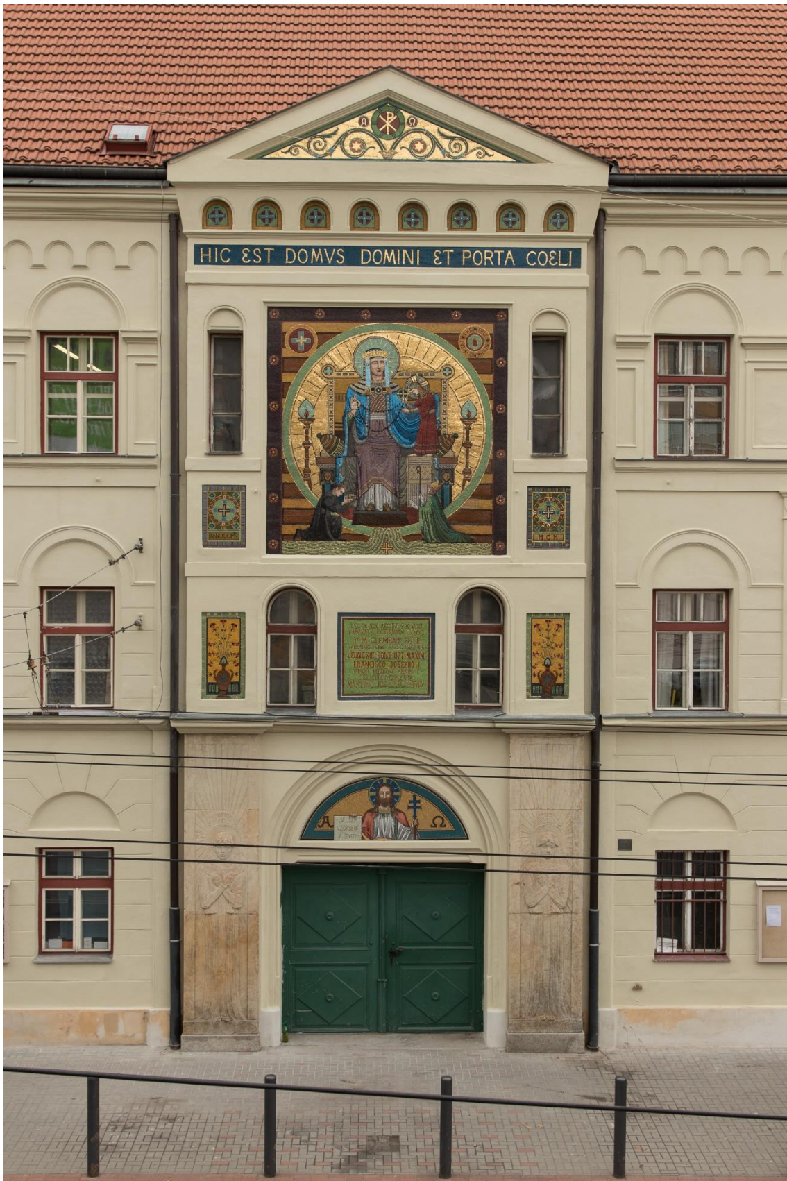
Celkový pohled fasádu s mozaikovou výzdobou. Stav po restaurování.
