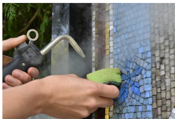
Obr. 34: Mozaika na náhrobku Jana Tumpacha na Vinohradském hřbitově. Průběh odstraňování tmavého povlaku. Odmývání nečistot pomocí parního čističe.
