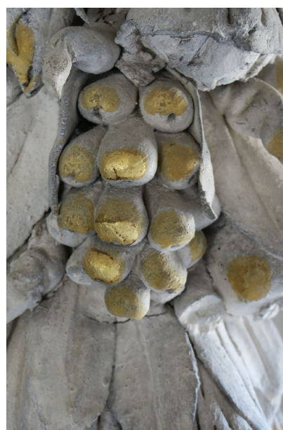
Obr. 22: Kaple Věch svatých, SZ Telč. Pohled do presbytáře se štukovým reliéfem Boha Otce (vlevo). Zlacení použito akcentové a malířské (dojmové) (vpravo); na širším malovaném okrovém pozadí jsou zlacené vrcholky štukové výzdoby pro podpoření reflexe světla.
