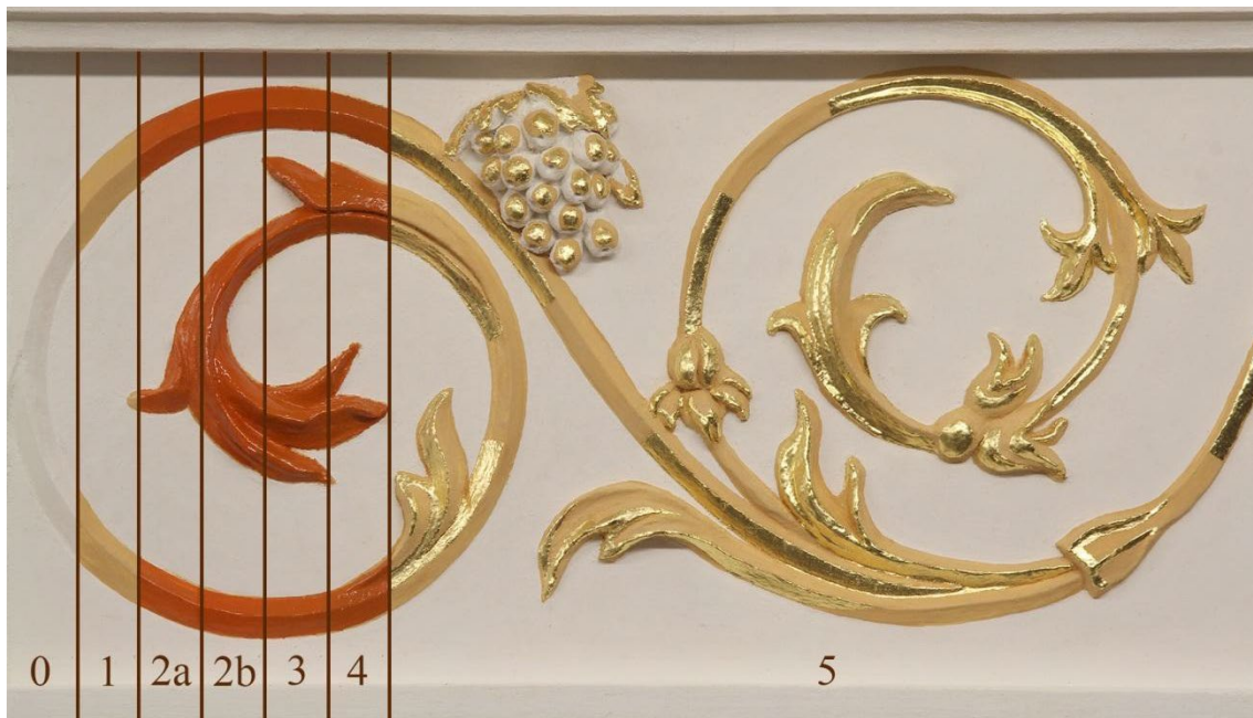
Obr. 32: Postup zlacení renesančního štukového díla dle kaple Věch svatých, SZ Telč. Foto: R. Zůfalá.
