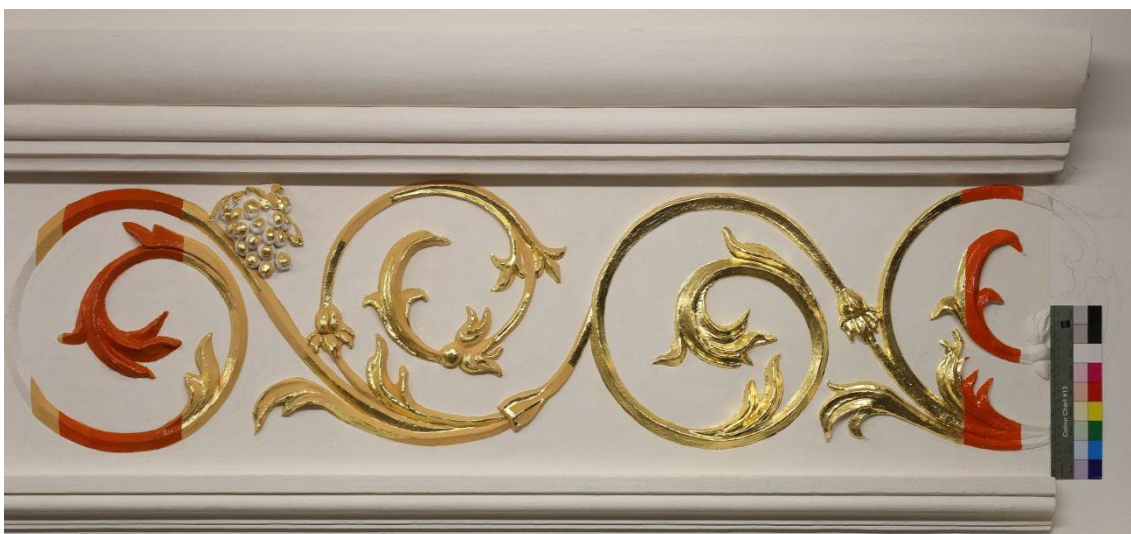
Obr. 36: Průběh pozlacování na mordant dle kaple Všech svatých (vlevo) a pozlacování na mixtion podle kaple sv. Jiří (vpravo). Foto: R. Zůfalá.
