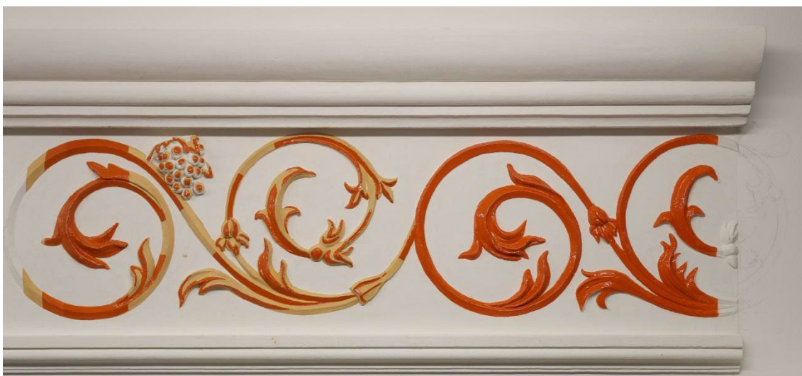
Obr. 35: Lokální provedení podkladových vrstev mordantu na replice mordantového zlacení dle kaple Všech svatých (vlevo) a zlacení na mixtion (vpravo). Foto: R. Zůfalá.
