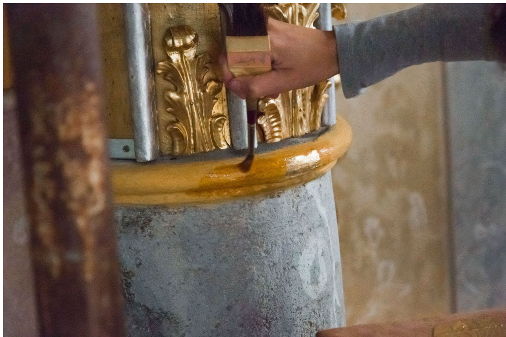
Obr. 5: Ukázka nanášení žlutého polimentu. Foto: V. Krajíček.
