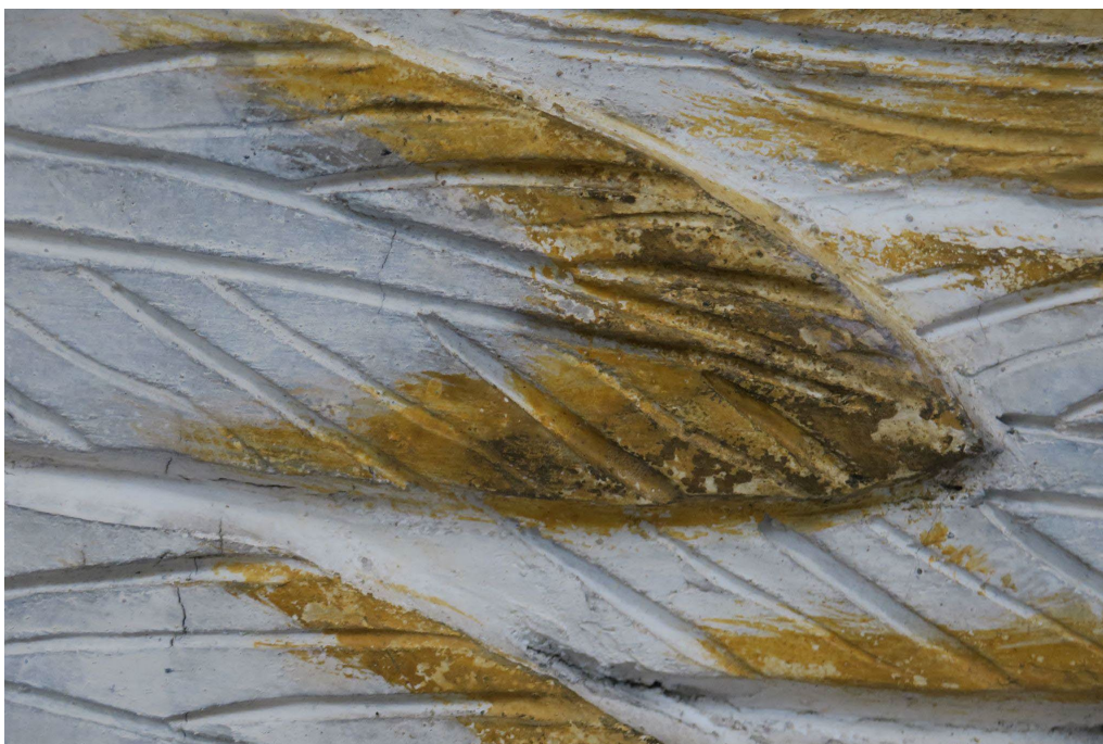
Obr. 13: Kaple Věch svatých, SZ Telč, detail renesančního zlacení ťtukové dekorace, současný stav. Zlacení bylo prováděno na širší, okrem malované pozadí technikou na mat, na olejové podklady. Foto: R. Zůfalá, 2021.
