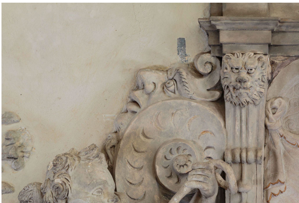
Obr. 11: Kostel sv. Jakuba Většího, Boskovice, náhrobek Václava st. Morkovského ze Zástřízl a Kunky z Korotína, současný stav. Detail štukové modelace. Zbytky původního zlacení nacházíme na volutě, festonech a lvíčcích na konzolách. Foto: V. Krajíček.
