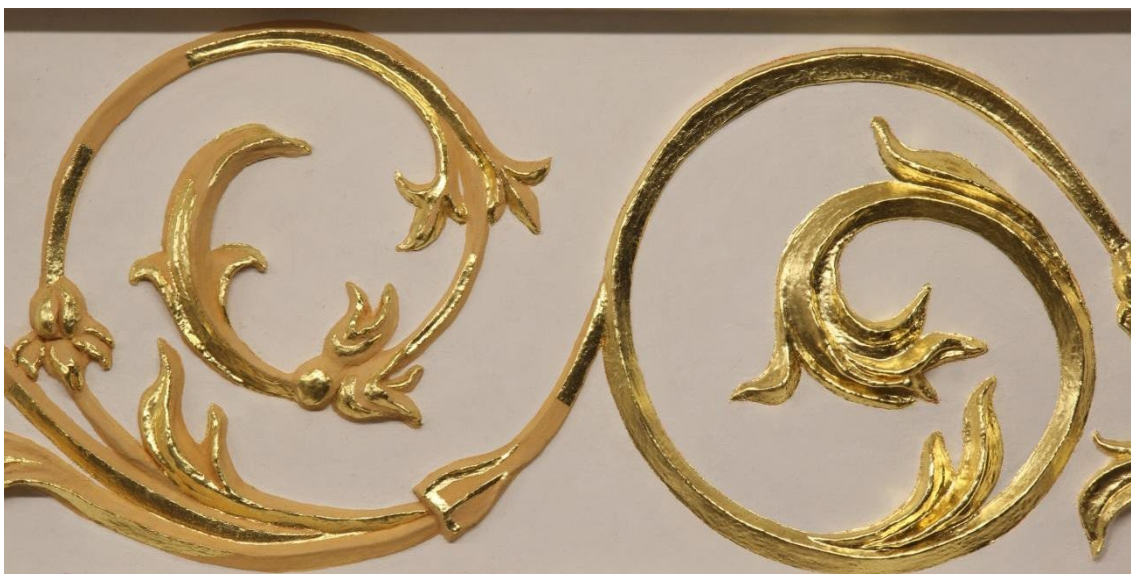
Obr. 37: Detaily pozlacených částí – akcentové zlacení na mordant dle kaple Všech svatých (vlevo) a celoplošné zlacení na mixtion podle kaple sv. Jiří (vpravo) zlacení. Foto: R. Zůfalá.
