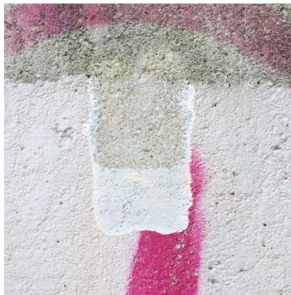
Obr. 22: Zkouška čištění laserem, v oblasti betonového monolitu, bílá vrstva.
