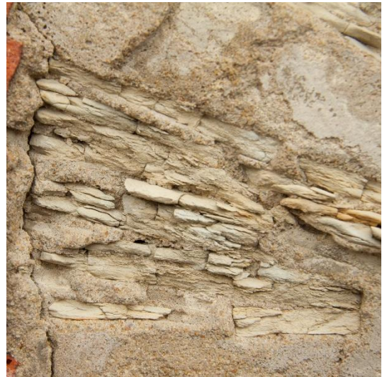
Obr. 3: Detail mozaiky – zvětrávání opukových kamenů osazených kolmo k maltovému loži.
