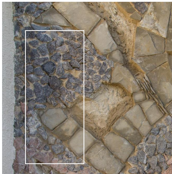
Obr. 14: Detail mozaiky Ptačí rodina – oblast s původně uvolněnými mozaikovými kameny po jejich opětovném osazení na novou ložnou maltu.
