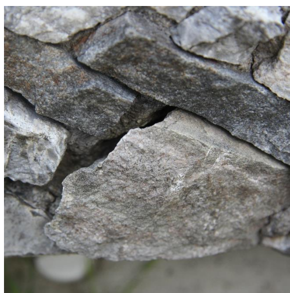
Obr. 12: Detail poškození mozaiky – ukázka uvolněných mozaikových kamenů.
