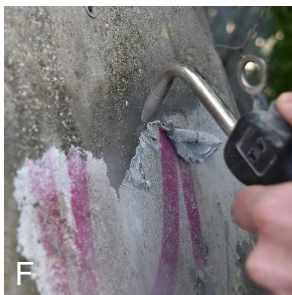
Obr. 23: Průběh zkoušek a následného čištění mozaiky na památníku obětem Pražského povstání v Praze-Barrandově pomocí mikrotryskání. A a B – zkoušky čištění (světlé oblasti představují části mozaiky po očištění), C a D – průběh čištění tryskáním, E – neúspěšná zkouška tryskání na silnějším nátěru, F – odstraňování nátěru párou po naměkčení pomocí mikroemulze.
