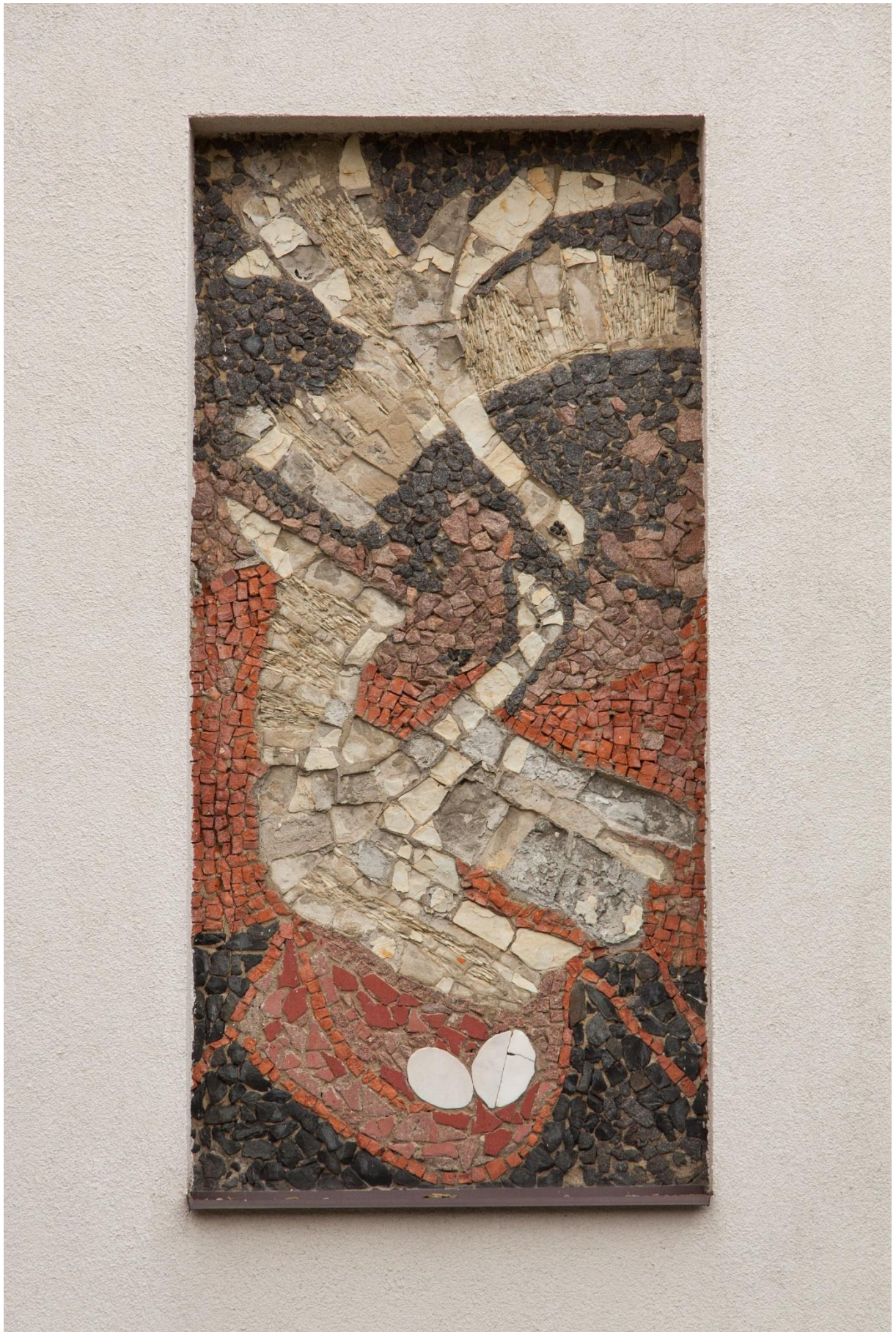
Obr. 1: Celkový pohled na mozaiku na mozaiku Ptačí rodina . Stav před restaurováním.
