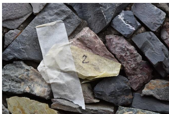
Obr. 24: Ukázka průběhu doplňování scházejících mozaikových kostek na mozaice M. Sladkého na památníku obětem Pražského povstání v Praze-Barrandově. Vlevo: kameny připravené na osazení; vpravo: stav po osazení na novou ložnou maltu ( Ledan TA1 tónovaný práškovými minerálními pigmenty).
