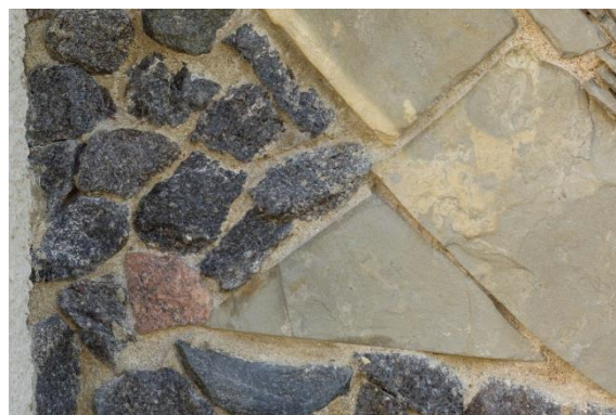
Detail levé horní části mozaiky. Stav výměně opukových kamenů.
