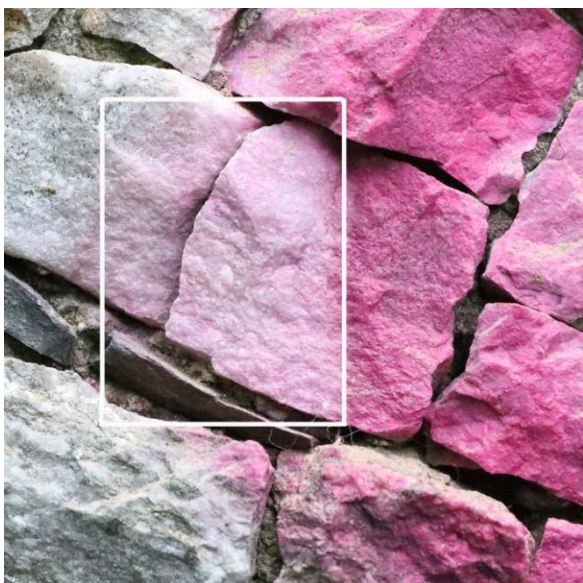
Obr. 17: Zkouška čištění acetonem na světlých kamenech.
