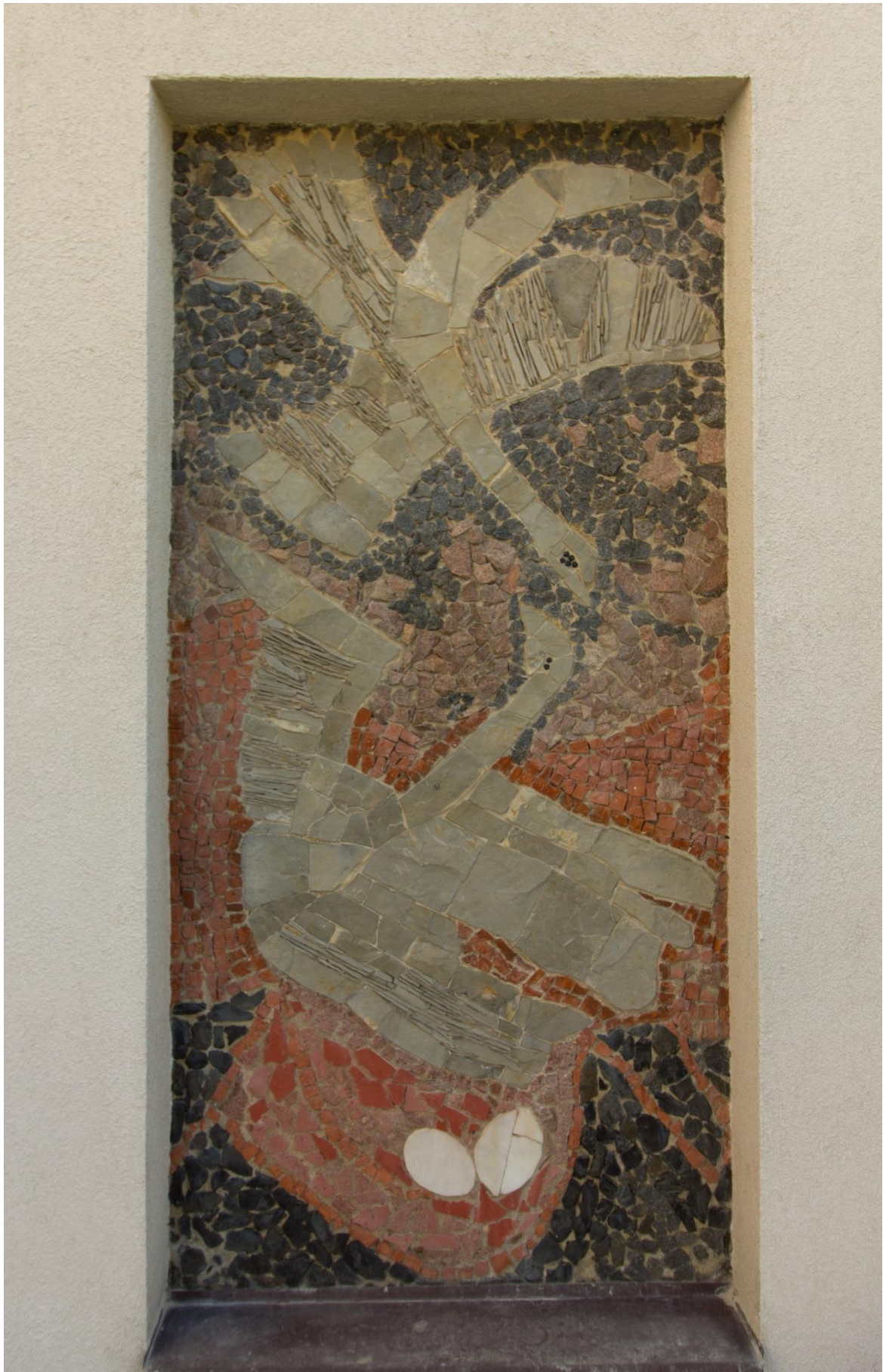
Obr. 26: Celkový pohled na mozaiku na mozaiku Ptačí rodina na ul. Lidická v Litomyšli. Stav po restaurování.
