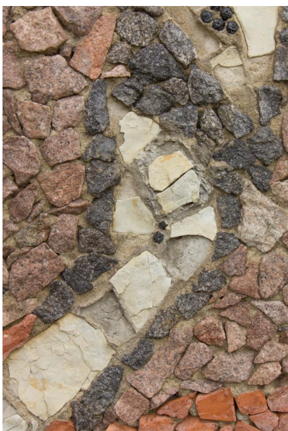
Detail hlavy spodního ptáka. Stav před restaurováním – degradované opukové kameny.
