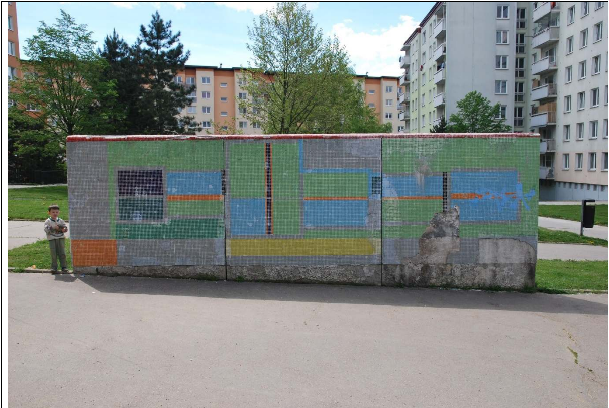
Stav před restaurováním, severní stěna
