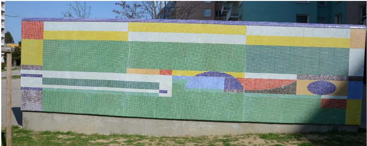
Obr. 28 Jižní stěna, stav po restaurování, duben 2019. Foto I. Kučerová
