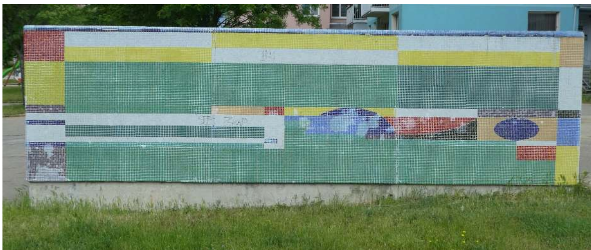
Obr. 22 Mozaika „Přítomnost člověka“ B. Matala – jižní stěna, stav před restaurováním. Foto Z. Křenková
