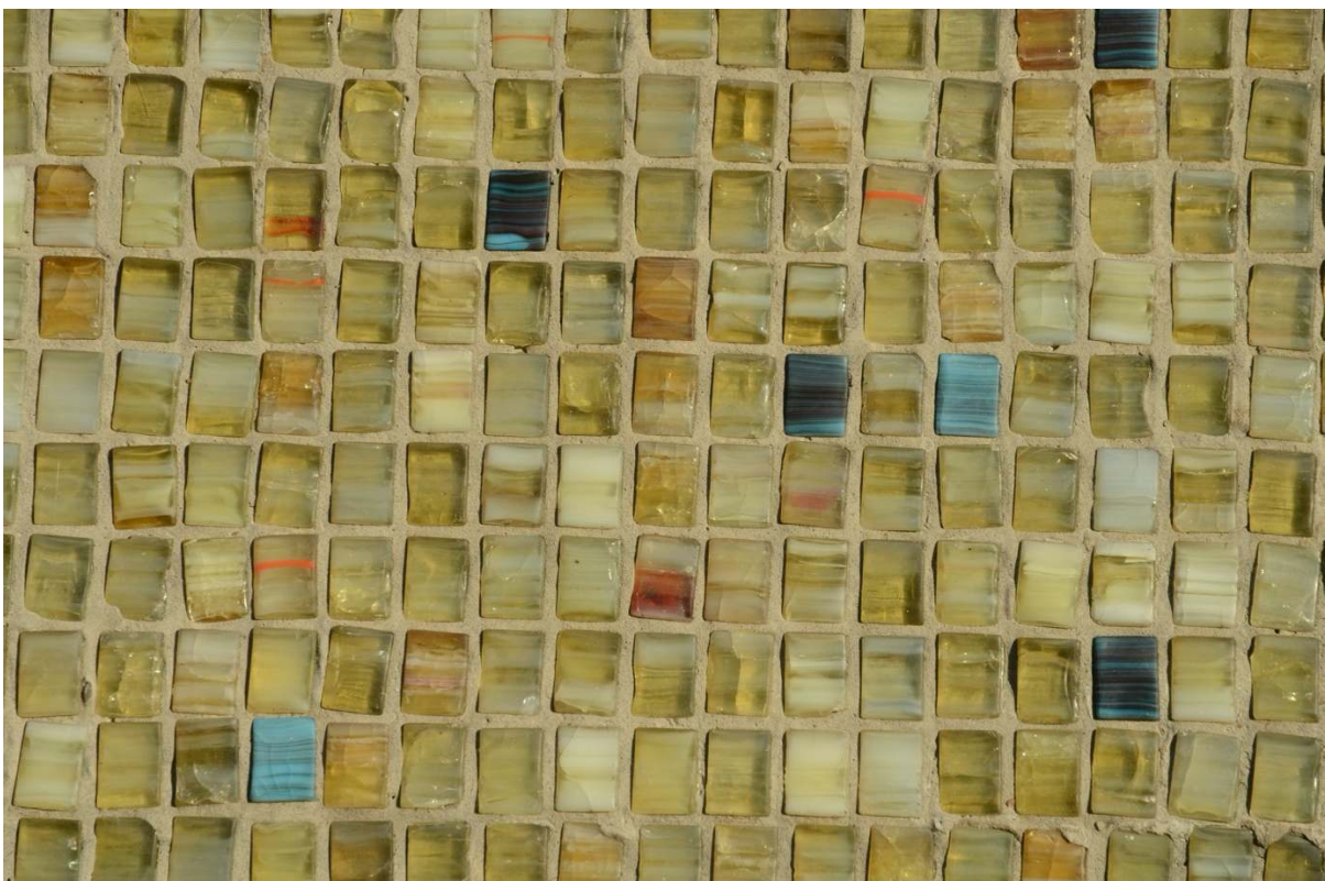
Obklad rodinného domu v Bakově nad Jizerou z rotačně mačkané mozaiky. Foto I. Kučerová
