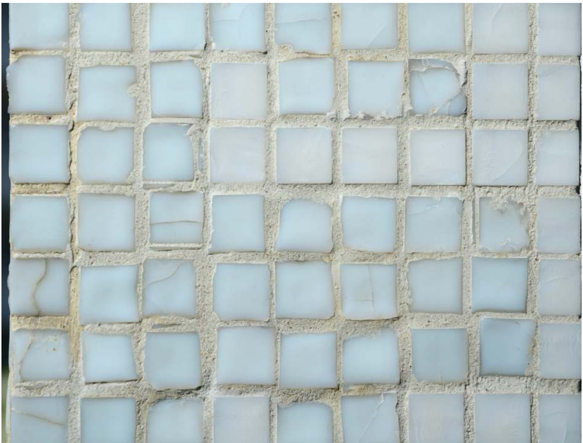
Obr. 26 Stav po restaurování – detail doplnění mozaiky replikami kostek bílé barvy. Foto I, Kučerová
