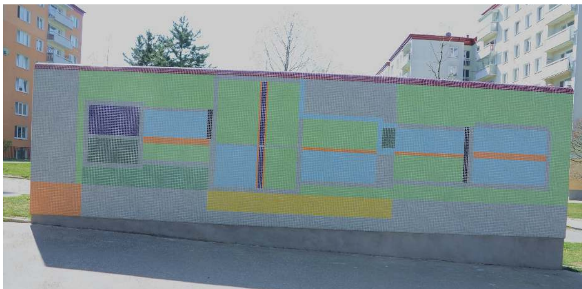
Obr. 27 Severní stěna – stav po restaurování, duben 2019. Foto I. Kučerová
