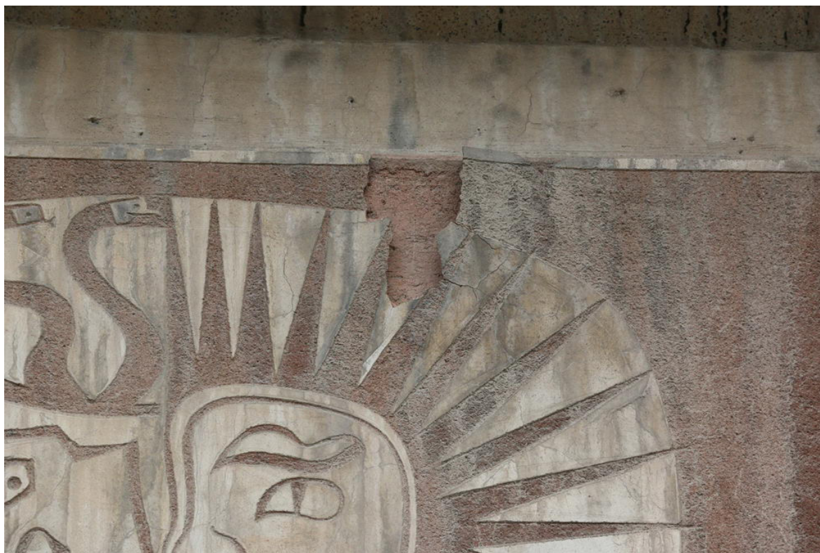
Obr. 14: Brno, Venhuda ulice. Detail stavu před restaurováním – odlupující se omítkové vrstvy a lokální odpadnutí omítky
