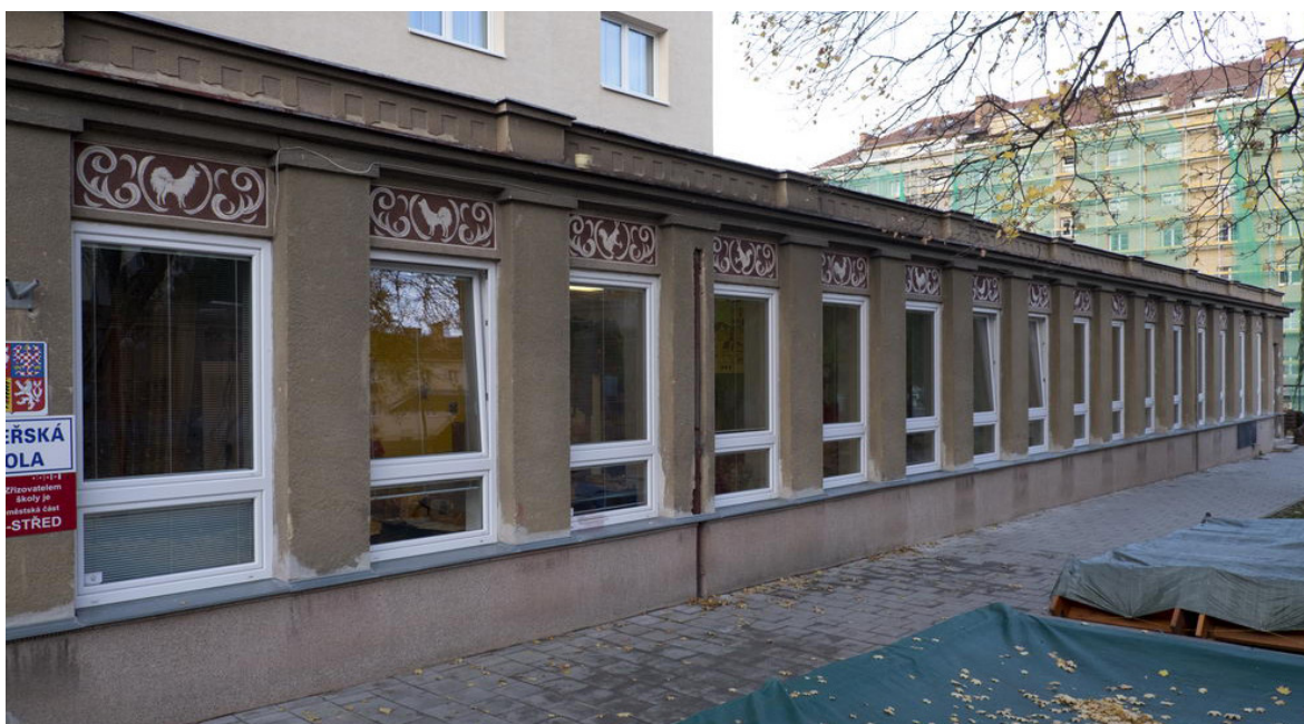
Obr. 9: Brno, MŠ Tučkova. Celkový pohled na fasádu se souborem sgrafit nad okny
