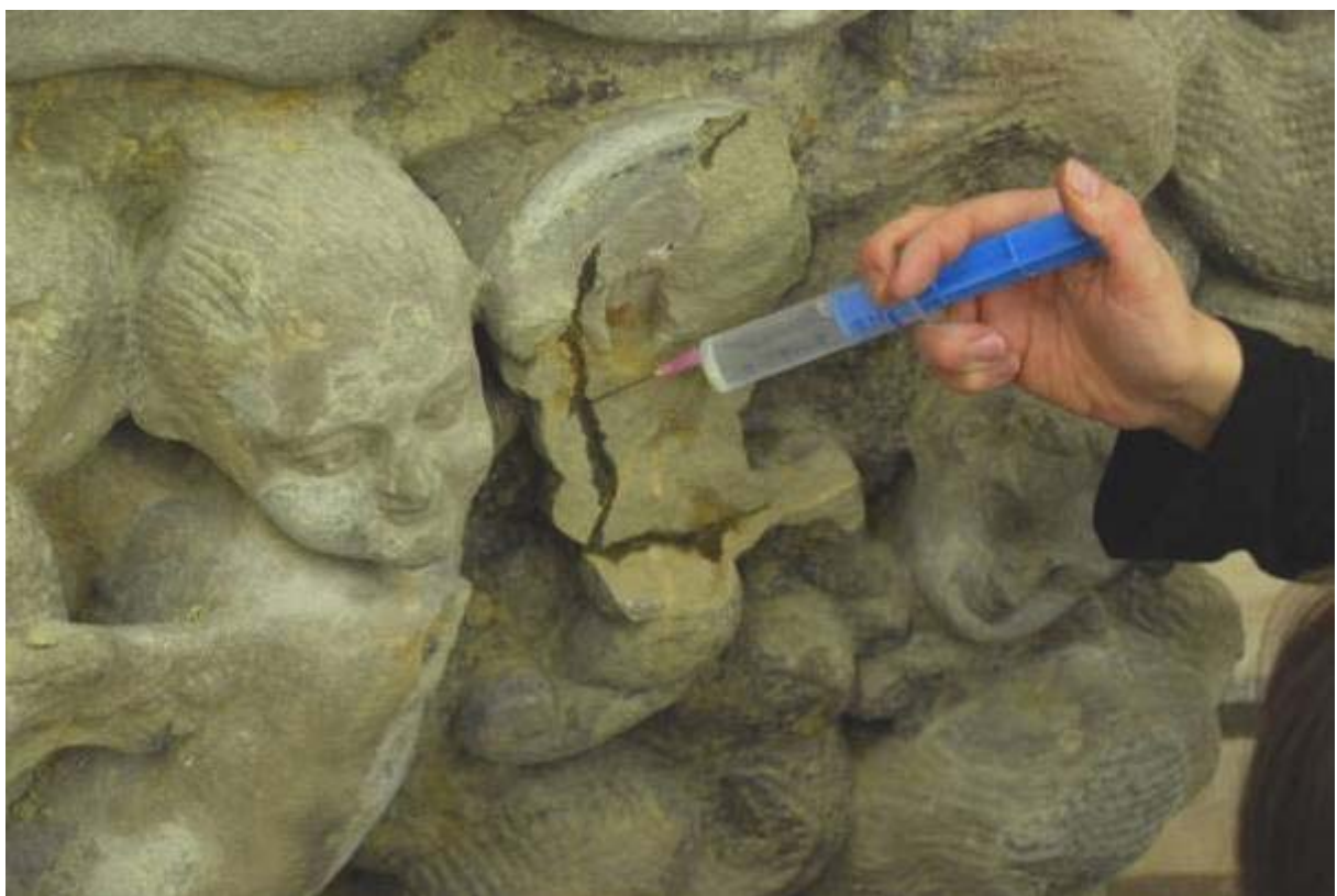
Injektáž 7,5 % roztokem Paraloidu B72 v xylenu.
