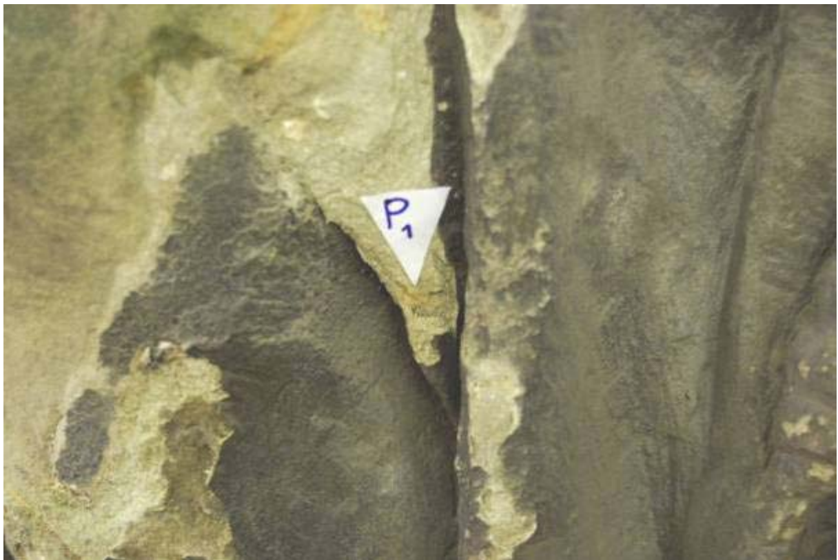
Zkoušky injektážích materiálů
