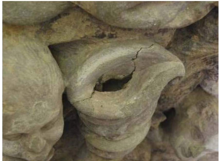
Odstraňování železných armatur, lepení rohu hojnosti.
