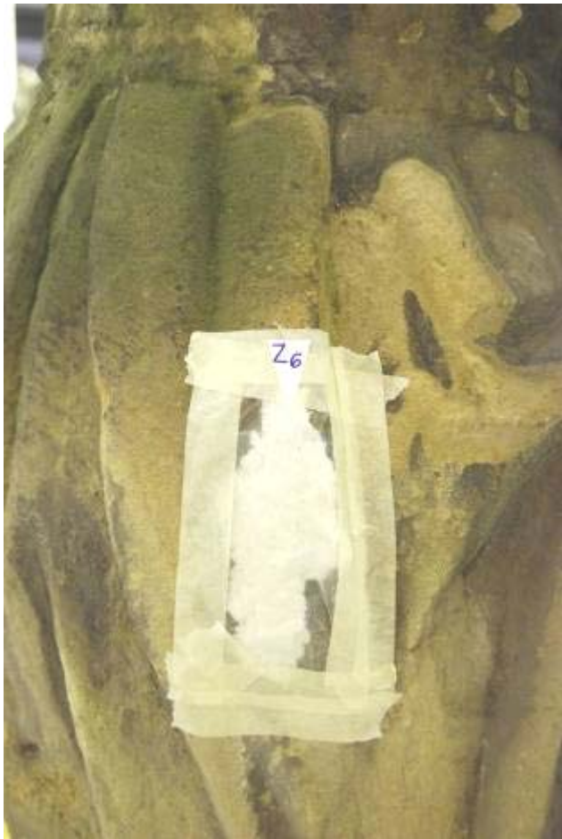
Odstraňování sádrovcových krust pomocí uhličitanu amonného.
