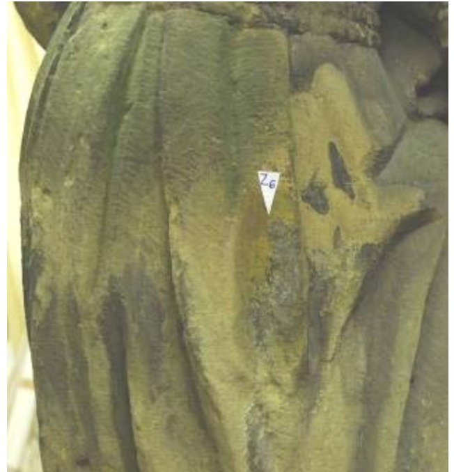
Odstraňování sádrovcových krust pomocí uhličitanu amonného.
