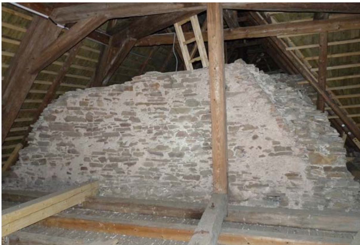
Obr. 26 Fragment konstrukce štítu nad vítězným obloukem, pohled ze západu, 2010. Foto: autorka
