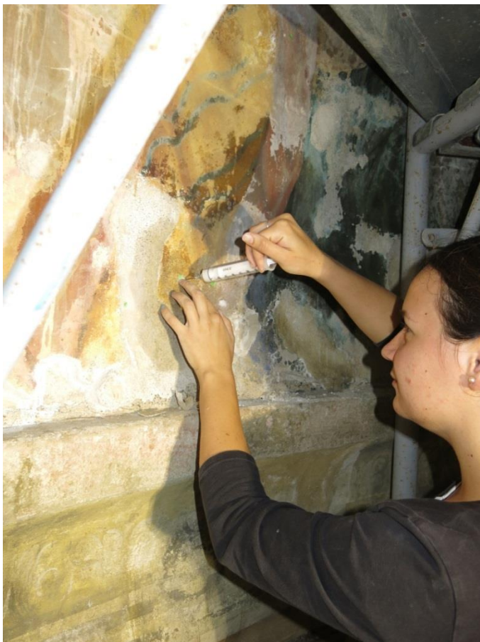
Postup prací - injektáž místa z obr.7
