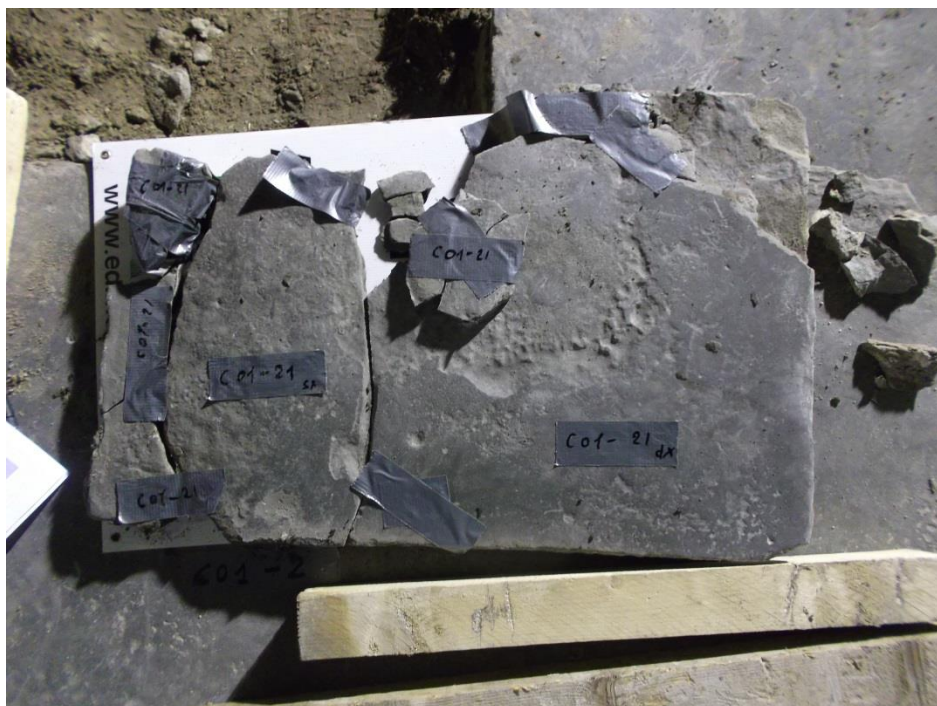
Příklad degradace nášlapné kamenné desky schodu po jejím vyjmutí z rampy a její nutné katalogizace
