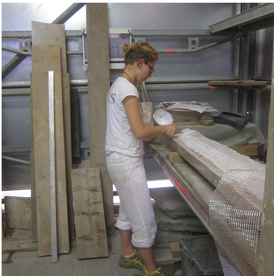
Lepení vertikální části schodu. Následné zpevňování z vnitřní strany skelnou mřížkou.
