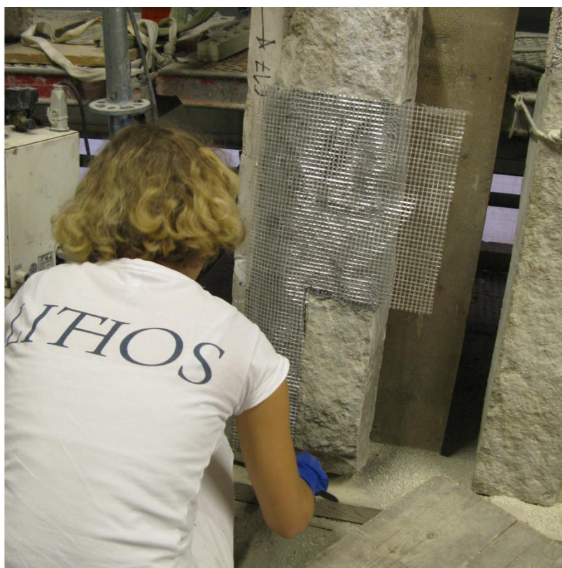
Příklad lepení vertikální vápencové části schodu a jeho následné zpevnění ze zadní strany.
