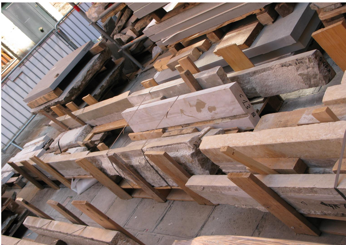
Již zrestaurované kamenné desky schodiště. Katalogizované – jednotlivé stupně schodiště na jednotlivých europaletách, připravené na zpětné umístění na schodišťovou rampu mostu.
