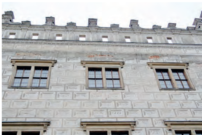
Obr. 6 (vlevo) Poškození severozápadní fasády v místě, kde byla v minulosti odstraněna lunetová římsa. Vzhledem k nedokonalému odstranění římsy došlo při provedení omítek k vytvoření vyčnívajících částí, které jsou přístupnější srážkové vodě. Následně vzniká poškození mrazovými cykly, vodorozpuštnými solemi i biologickou degradací (řasy). (Foto J. Vojtěchovský, 2011)
