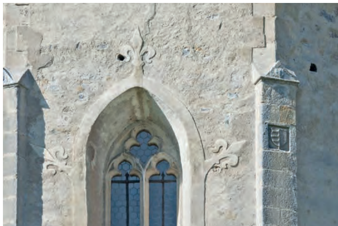
Obr. 5 Švihov, detail okna kaple s nenásilným zvýrazněním lilií ukončujících omítkové pasparty. (Foto Gabriela Čápková)
