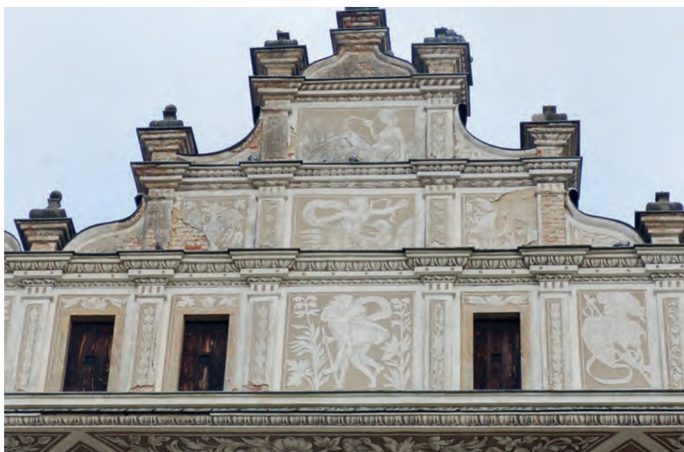
Obr. 8 (nahoře) Pohled na část atiky jihozápadní fasády. Omítky jsou výrazně destruovány, některé její části již odpadly. V pravé části snímku pozorujeme odhalené poškozené originální sgrafitové výzdoby. (Foto J. Vojtěchovský, 2011)
