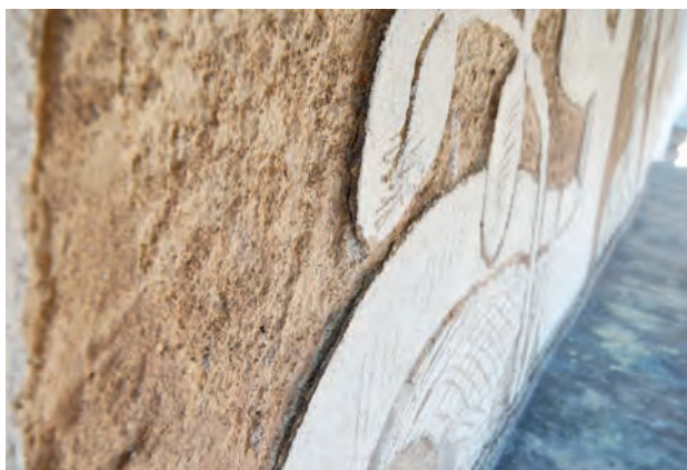
Obr. 9 (vpravo) Detail nejzápadnější lunety horního sgrafitového pásu – patrné oddělování intonaco bianca i se vrchní vrstvou intonaco colorata. (Foto M. Vedral, 2012)
