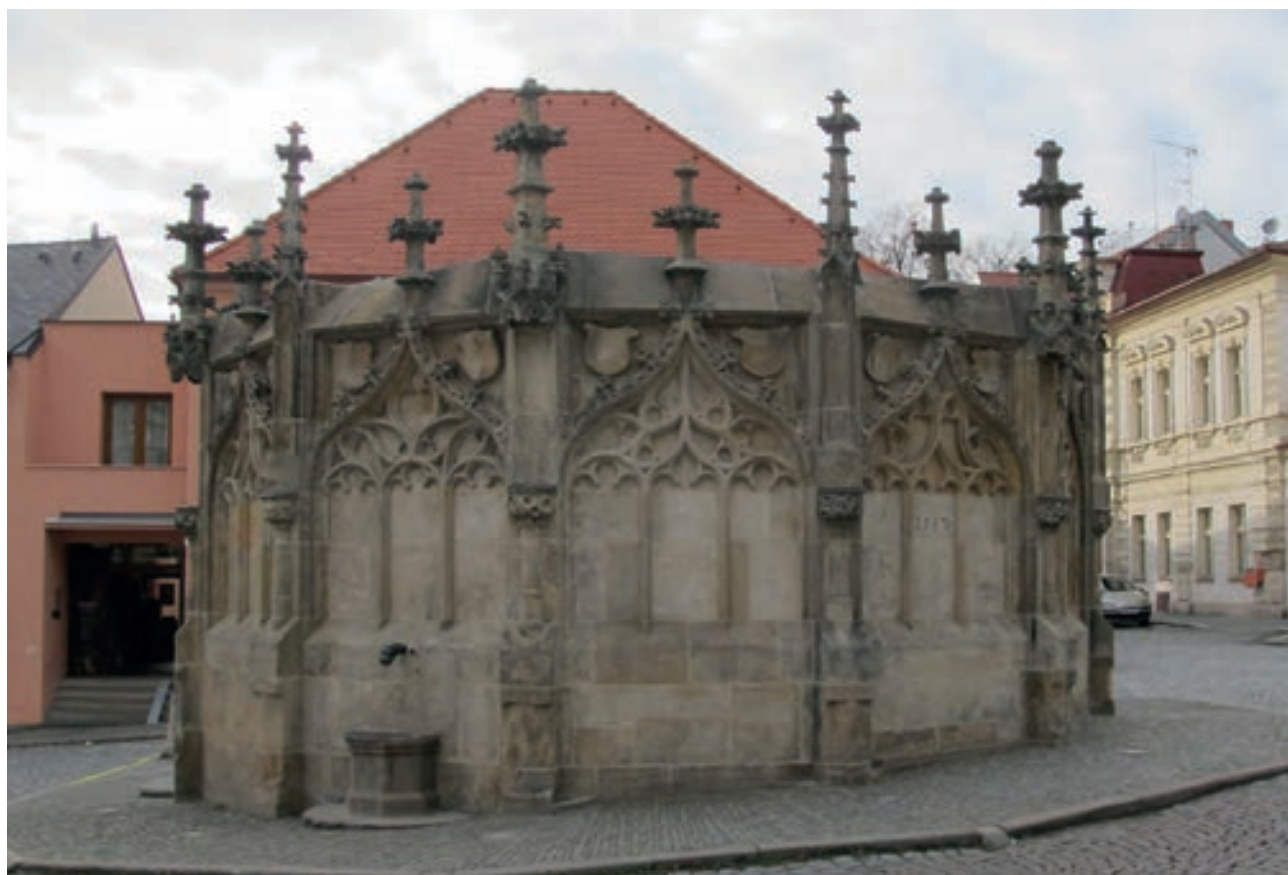
Stav po dokončení prací.
