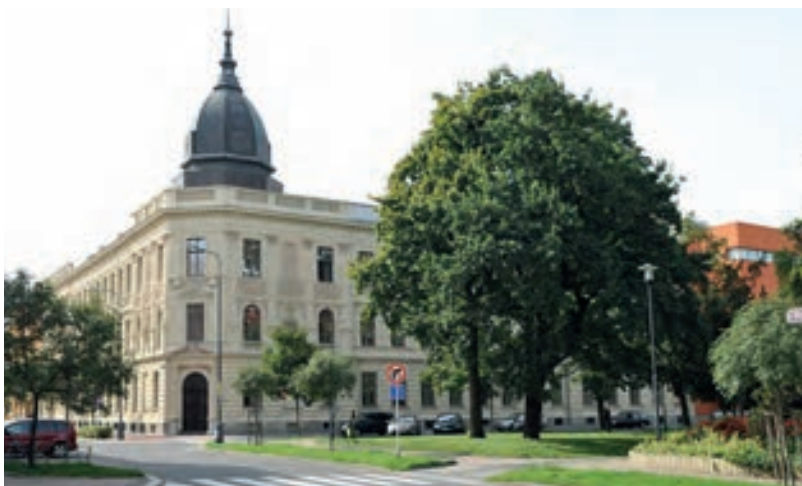
Pohled na fasádu po dokončení prací.
