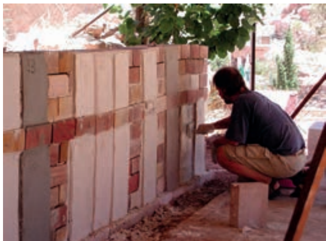
Zkoušky doplňovacích malt na zkušební zdi.
