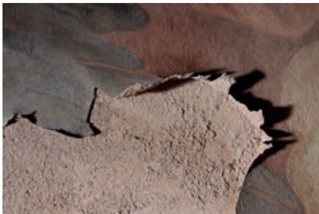
Typická poškození nástěnné malby: odlupování barevné vrstvy od podkladu a krystalizace vodorozpustných solí.
