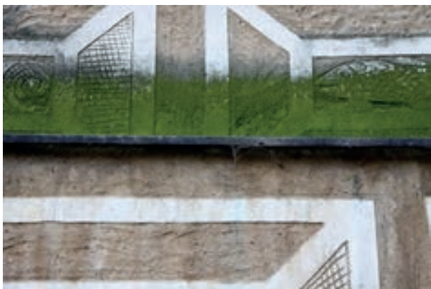
Biologické napadení – masivní růst zelených řas v místech zatěžovaných srážkovou vlhkostí (především deštěm).
