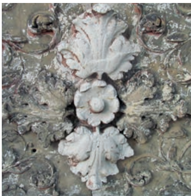
Průběh prací – restaurování ornamentálních prvků fasády.
