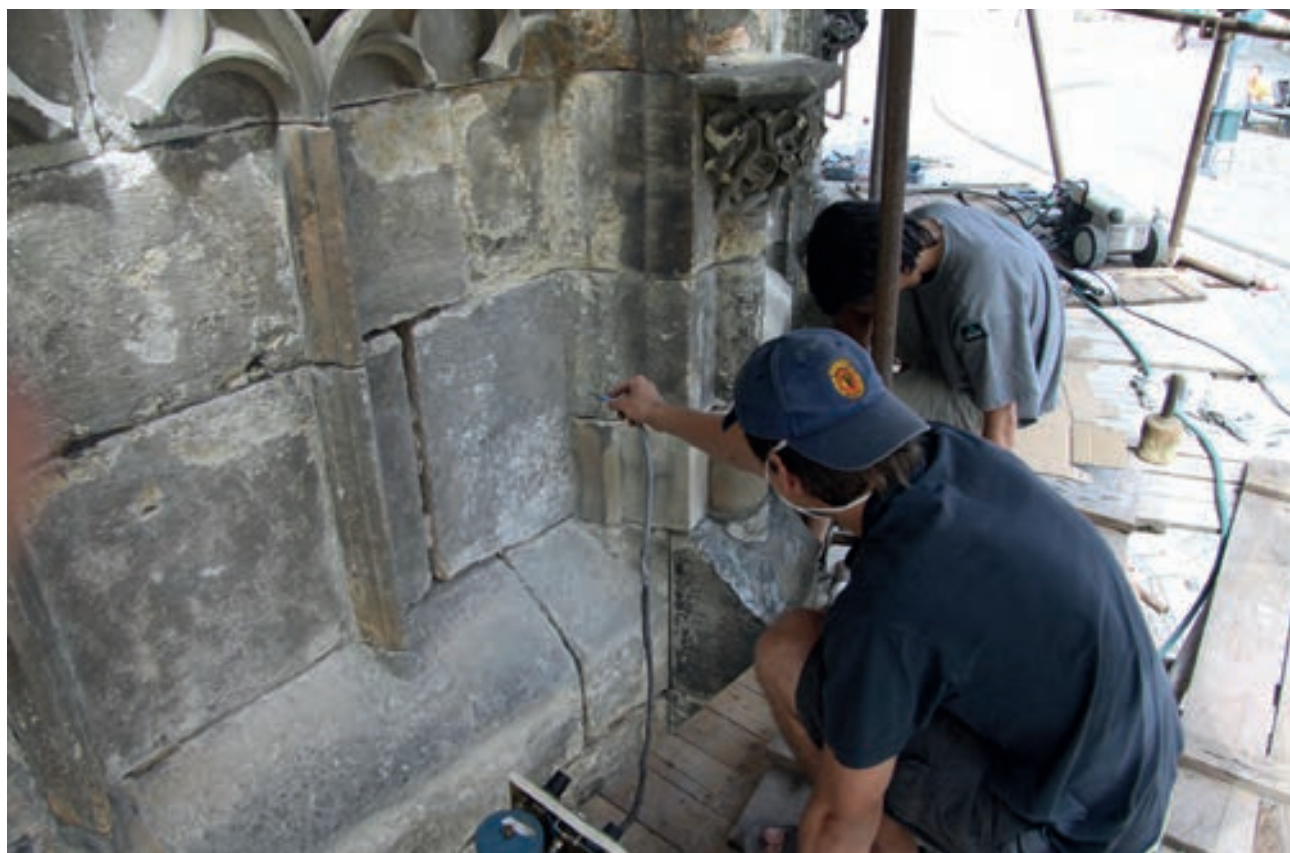
Průběh prací, čištění pomocí mikrootryskávání.
