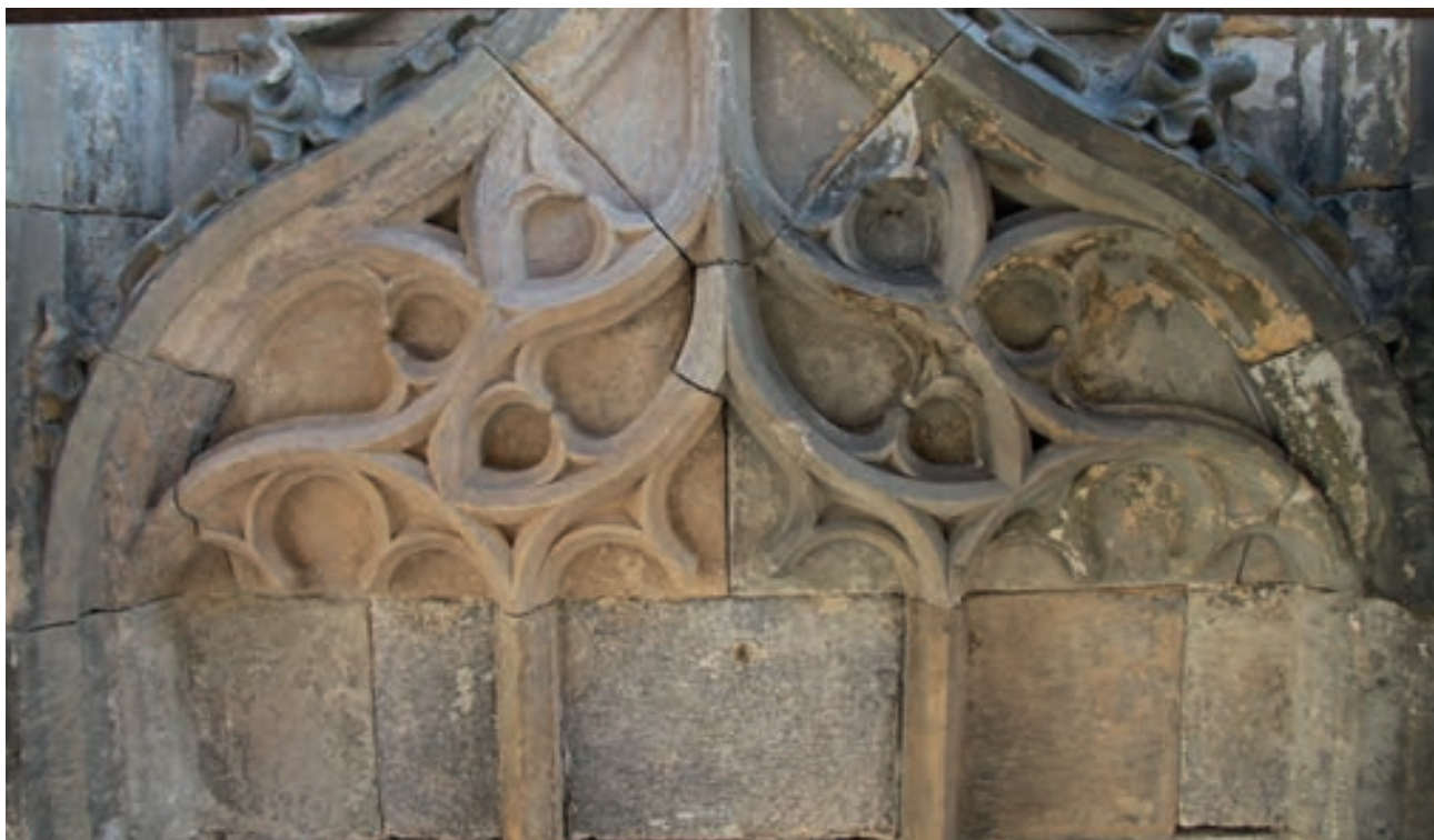
Průběh prací, stav po částečném očištění.
