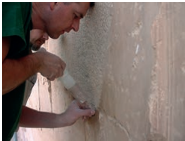
Testování injektážních prostředků pro stabilizaci omítek.
