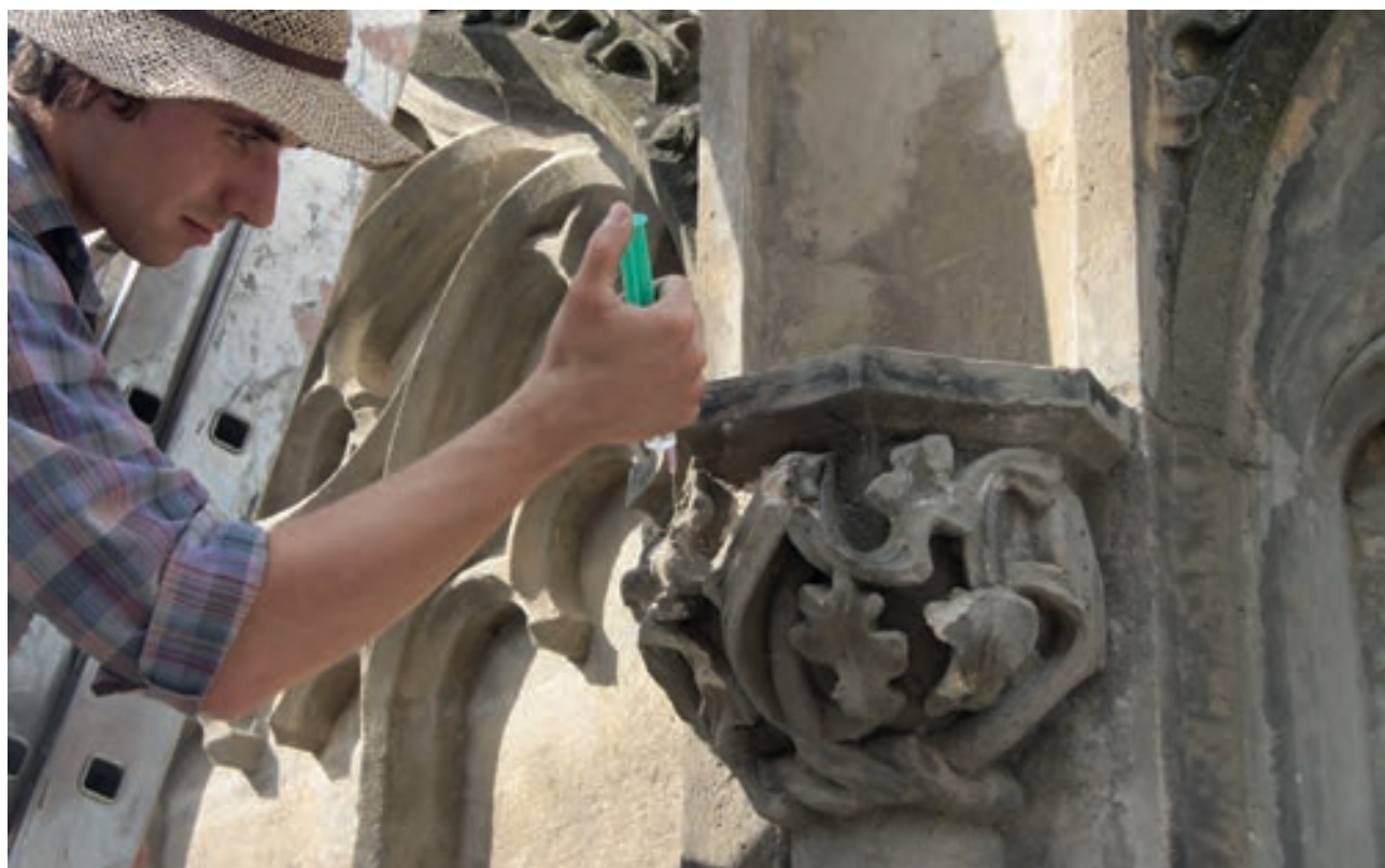
Průběh prací, zajištění narušeného kamene.
