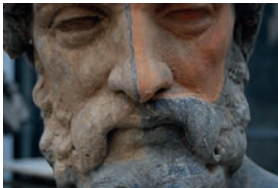
Původní barevnost originálního materiálu (vlevo) byla často pozměněna v průběhu novodobějších úprav fasády.
