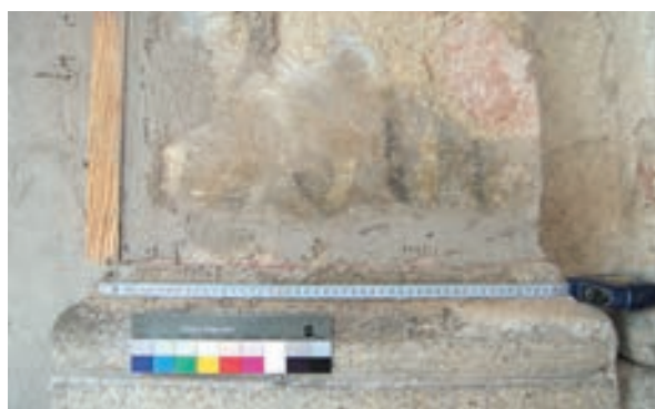
Obr. 7: Pozůstatek původní omítky s fragmentem malované kanelury zachovaný u patky pilastru na zahradní straně Rondelu
