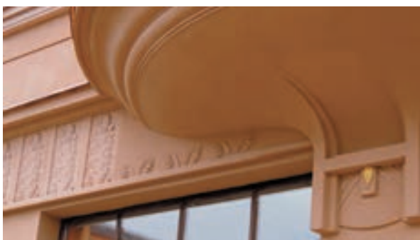
Obr. 17: Dvůr Králové nad Labem, náměstí T. G. Masaryka č. p. 57, detail nově provedené kordonové římsy s vlysem a arkýřové konzoly (foto J. Kašpar)
