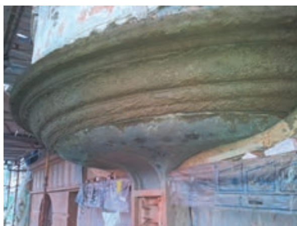
Obr. 16: Dvůr Králové n. L., náměstí T. G. Masaryka č. p. 57, průběh prací na chybějící konzole arkýře (foto J. Kašpar)
