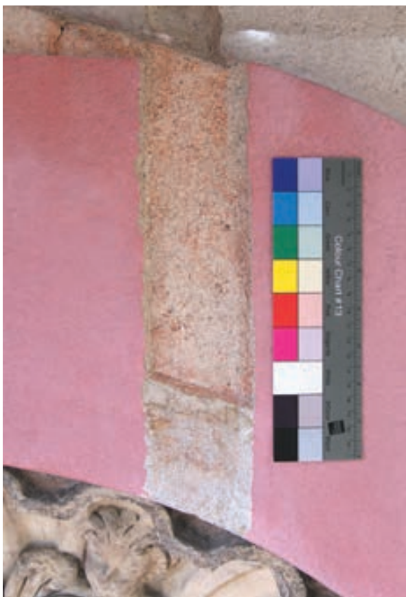
Obr. 3: Omítka s hrubým povrchem a červeným nátěrem s mramorováním z nejstarší, provizorní úpravy Rondelu (sonda nad nikou v zahradním průčelí)
