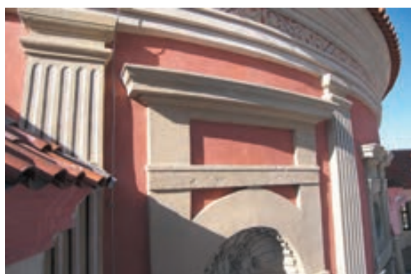
Obr. 12: Část přízemní části po rekonstrukci. Malovaná kanelura na pilastrech, vlys pod římsou a lazurně patinované kamenné prvky (hlavice pilastrů, římsy nad nikou)
