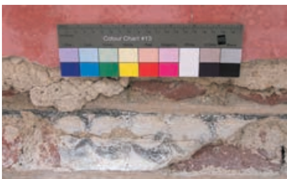
Obr. 4: Fragment malovaného perlovce na korunní římsě tamburu
