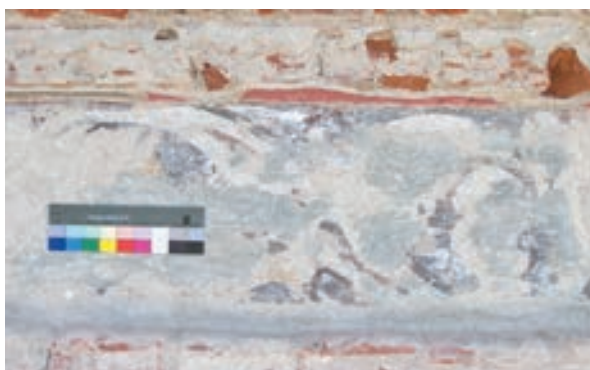
Obr. 6: Fragment malovaného vlysu pod cementovým nátěrem zachovaný na vnější straně Rondelu
