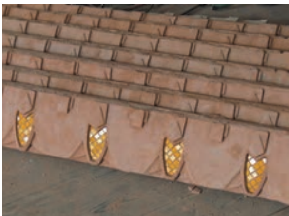
Obr. 13: Dvůr Králové nad Labem, náměstí T. G. Masaryka č. p. 57, nově provedené segmenty římsy s vlysem (foto J. Kašpar)
