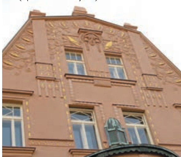
Obr. 19: Detail nově provedené štukové výzdoby štítu (foto M. Kudrnovský)
