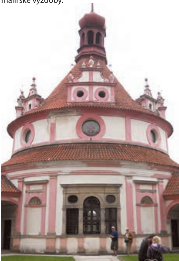
Obr. 1: Státní hrad a zámek Jindřichův Hradec, hudební pavilon Rondel. Pohled na Rondel ze zámecké zahrady před rekonstrukcí (2010). V ahistorickém barevném řešení z opravy v r. 1994 se nelogicky uplatňují kamenné prvky (všechna foto J. Bláha)
