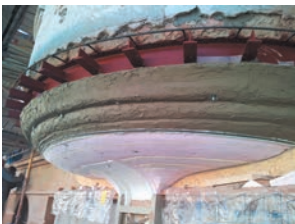
Obr. 16: Dvůr Králové n. L., náměstí T. G. Masaryka č. p. 57, průběh prací na chybějící konzole arkýře (foto J. Kašpar)
