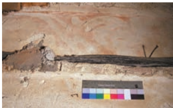
Obr. 5: Pozůstatek původní omítky s fragmentem malovaného vlysu zachovaný pod krovem novější (pravé) arkády
