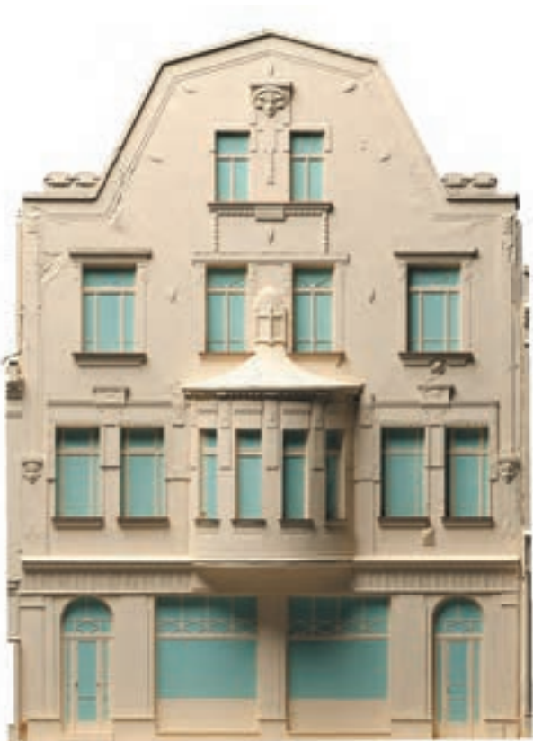
Obr. 3: Dvůr Králové nad Labem, náměstí T. G. Masaryka č. p. 57, detailní ortopohled na digitální polygonový 3D model fasády (Kudrnovský M., Obnova fasád objektu č. p. 57 ve Dvoře Králové n.L. , 2012)
