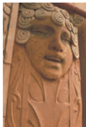
Obr. 8: Dvůr Králové nad Labem, náměstí T. G. Masaryka č. p. 57, původní modelovaná štuková výzdoba v průběhu odstraňování recentních nátěrů (foto J. Kašpar)
