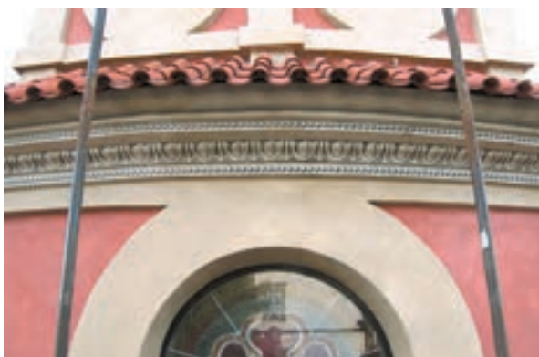
Obr. 11: Korunní římsa tamburu po rekonstrukci malby
