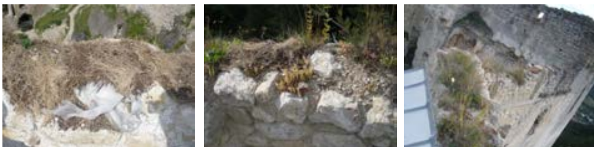
obrázky č. 13, č. 14, č. 15: aplikovaný výskum stabilizácie koruny hradných murív pomocou rôznych druhov trávovej mačiny (foto: archív autora)
