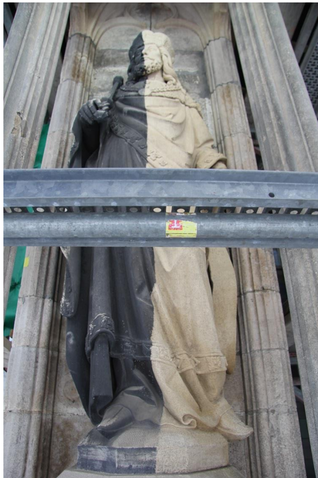
obr. 2 Proces čištění vápencové sochy na fasádě St. Stephansdomu.
