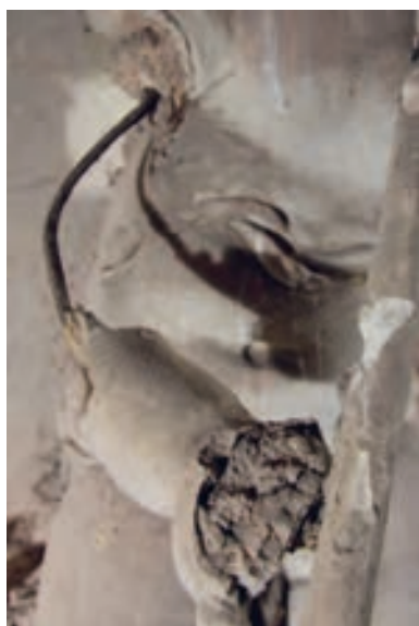
Obr. 2: Detail poškozené ruky
