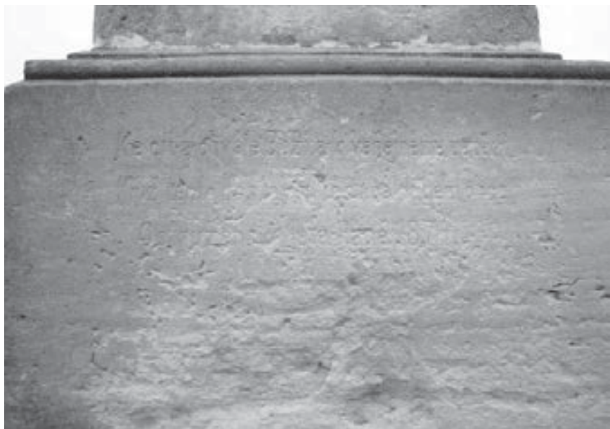
Detail nápisu poničeného korozí kamene.
