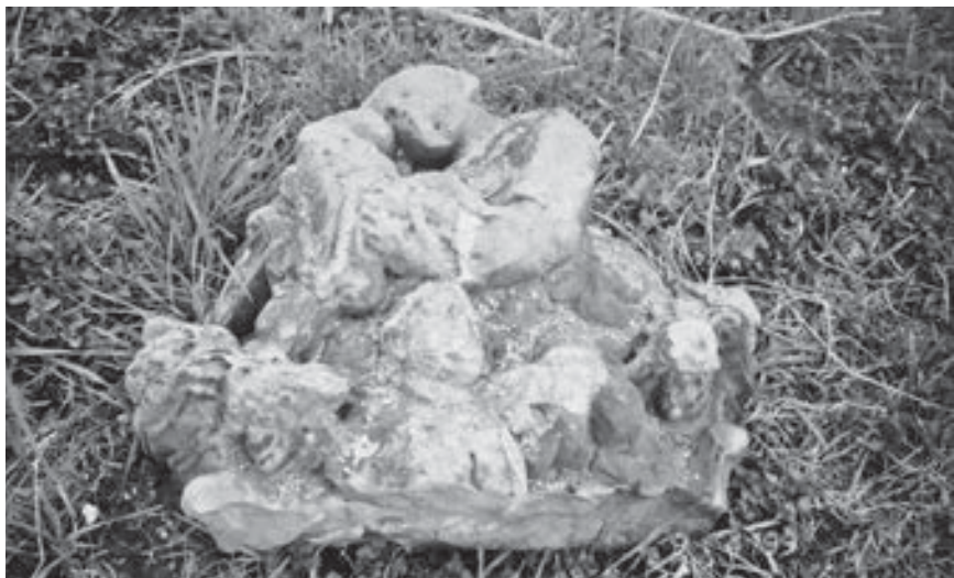
Vrcholová část pylonu s poprsím sv. Antonína Paduánského s Ježíškem po poničení, 1999.
