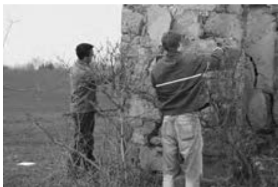
Měřičská dokumentace devastované kapličky u Kostece
