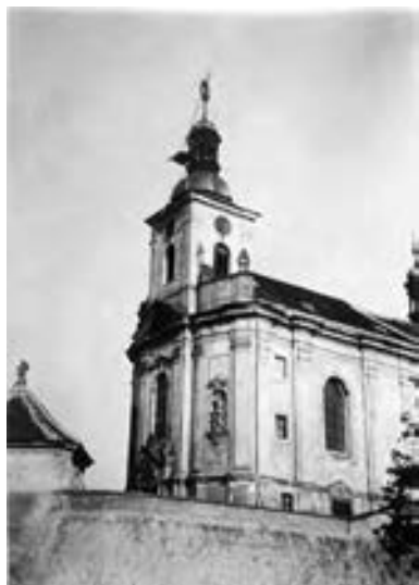
Kostel při opravě (nátěr, plechování) v roce 1945
