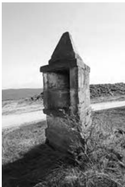
Současný stav kapličky, foto 2010
