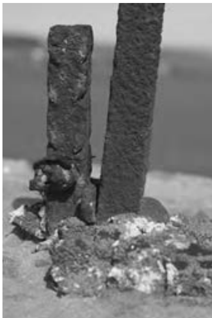
Detail uchycení litinového kříže u staršího čepu
