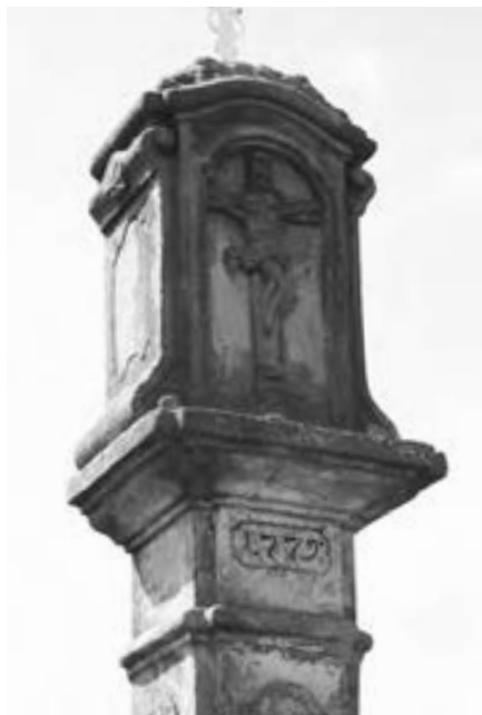
Detail vrcholové kaplice s datací, foto 2010
