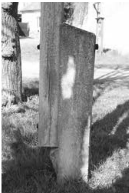
Uchycení dřevěného břevna k betonovému soklu
