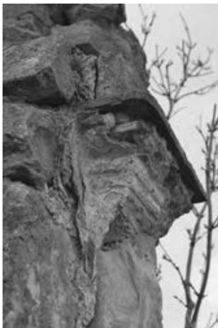
Detail hlavice pilastru se zbytkem omítky a nátěru
