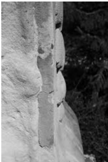
Detail omyté části reliéfu soklu s novodobým tmelem
