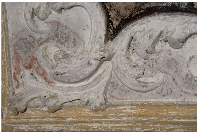
Obr. 7. Klanění pastýřů na vítězném oblouku, detail štukového pole pod výjevem. Stav před restaurováním (nahore). Stav po odstranění druhotných nátěrů s patrnou částí latinského verše (dole). Foto: Martina Poláková.
